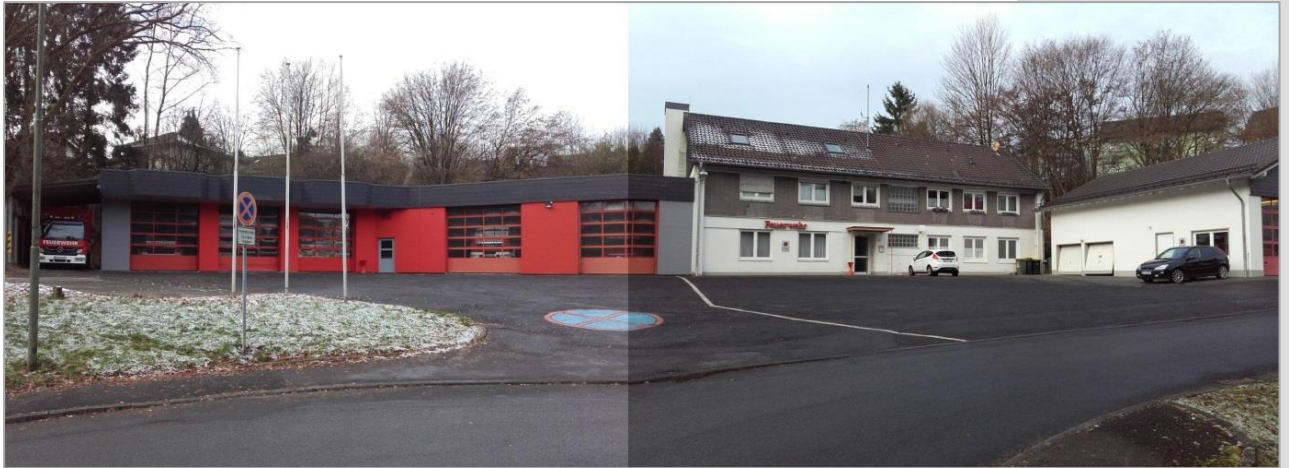
Abbildung 47: Außenansicht der Feuerwache Much Quelle: Gemeinde Much.
