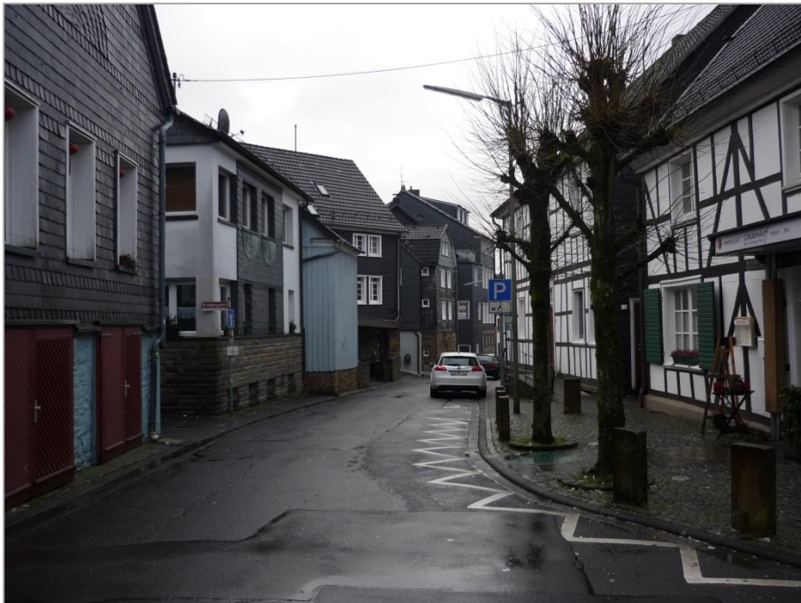
Abbildung 64: marode Straßenoberflächen und denkmalgeschützte Fassaden Quelle: Planungsgruppe MWM, eigene Aufnahme.
