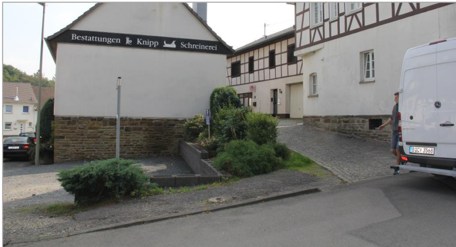
Abbildung 72: Marode Gehwegsbereiche Quelle: Planungsgruppe MWM, eigene Aufnahme.
