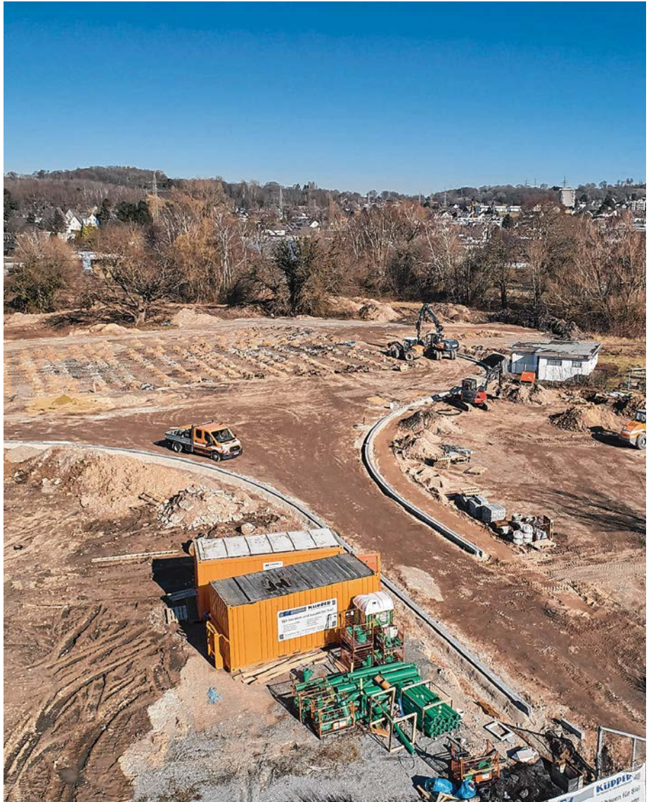
Der Bauplatz für das neue Blockheizkraftwerk am Schwarzen Weg in Aachen wird vorbereitet. Seinen Betrieb soll das BHKW im September 2022 aufnehmen.
