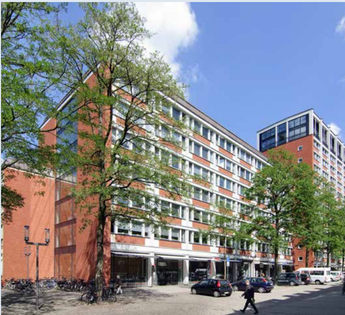
Denkmalgeschütztes Stadthaus nach der Sanierung
