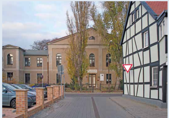
Saniertes evangelisches Gemeindehaus
