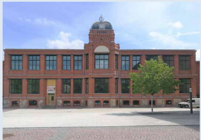
Im Umbau befindliches Verwaltungsgebäude zum neuen Rathaus
