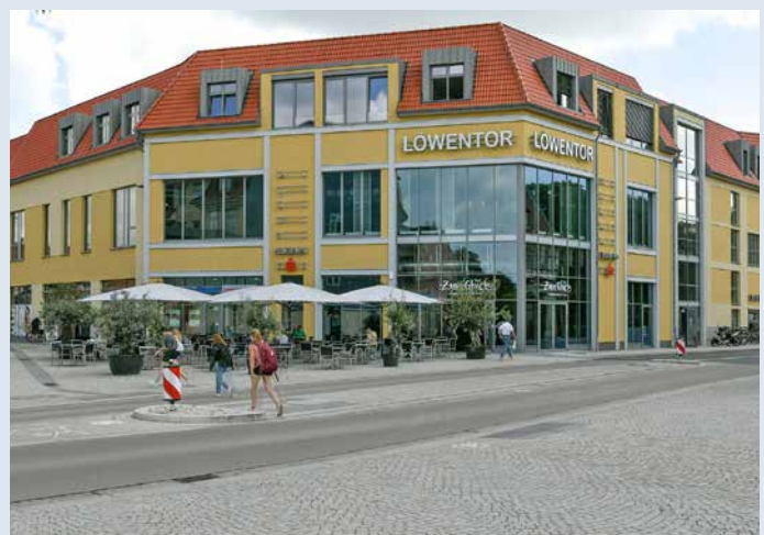
Löwentor Wolfenbüttel: neues Einzelhandels- und Bürogebäude
