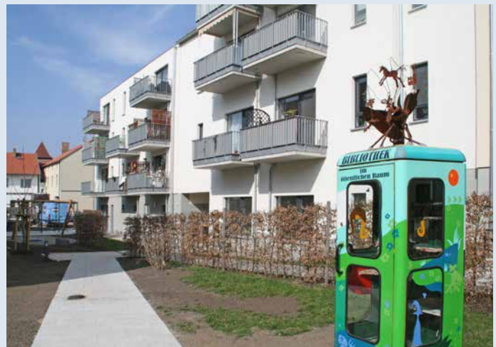
Sanierter Blockinnenbereich mit Bücherbox im Vordergrund
