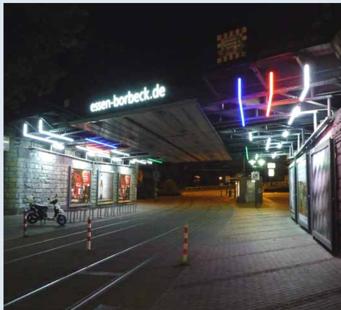
Neue Lichtinstallation der Bahnunterführung
