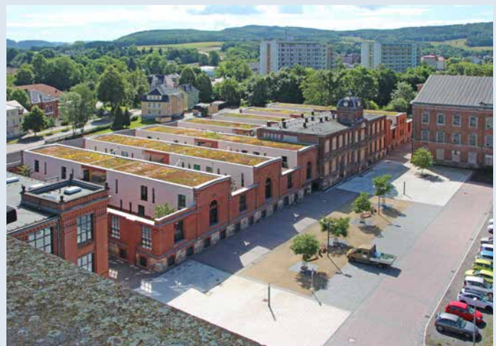
Neubauten hinter der historischen Fassade schaffen Funktionsvielfalt.
