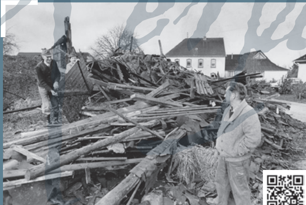
SA Schleiden, Bildsammlung: Durch Orkanböen zerstörte Fachwerkscheune in Kerperscheid, 1984. (© Manfred Hilgers)
