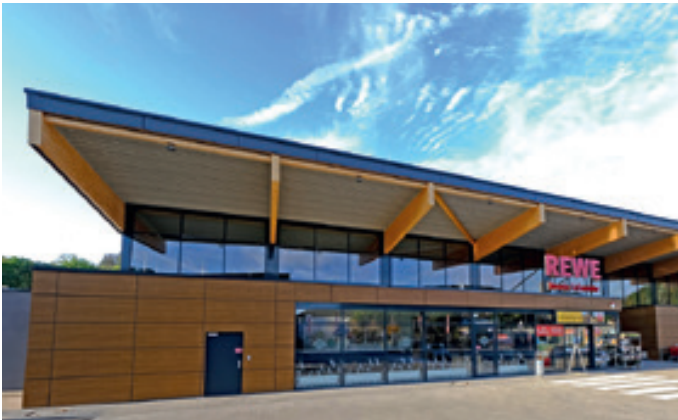
Das Beispielbild zeigt einen REWE Markt nach dem Green Building-Konzept in Gummersbach-Niederseßmar. (© REWE)
