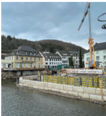
Noch ist vom Platz nicht viel zu sehen: Ab Sommer 2021 soll der malerische Platz „Am Nepomuk“ wieder zum Verweilen einladen. (© Gudrun Klinkhammer / www.gkli.de)
