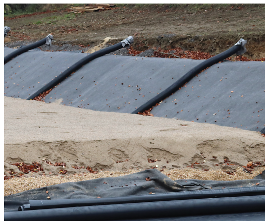
Bodenfilter Querschnitt: Das Foto veranschaulicht den Aufbau des Beckens: Auf eine fest verschweißte Folie werden Drainagerohre und eine Drainageschicht aus Kies aufgebracht, ehe eine Sandschicht folgt. Hier wird später noch Schilf eingepflanzt.
