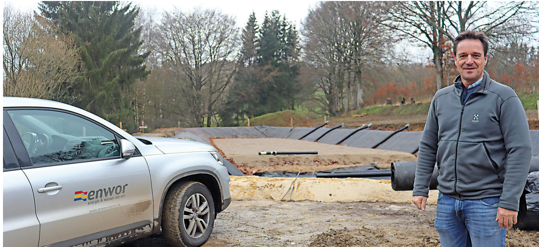
Bodenfilter Baustelle: enwor Fachbereichsleiter Dirk Delsemmé hält den Baufortschritt des neuen Bodenfilterbeckens regelmäßig im Auge. Fotos: enwor/ Ramona Kofferath
