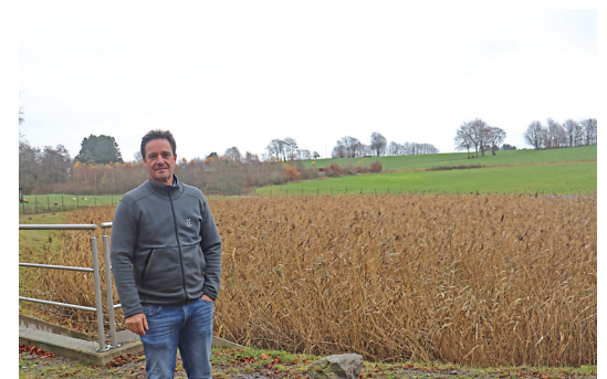
Bodenfilter in Betrieb: Ist der Bodenfilter in Betrieb, wirkt das Ganze recht unscheinbar. „Allerdings ist das Schilf im Frühjahr und Sommer schöner anzusehen“, weiß Dirk Delsemmé.
