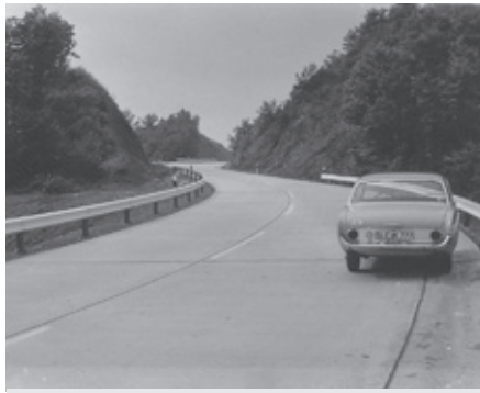
SA Schleiden: Zwei Jahre später, 1964, ist die Panzerstraße („Panzestrooß“) in Beton ausgebaut, um auch schwere Kettenfahrzeuge tragen zu können.
