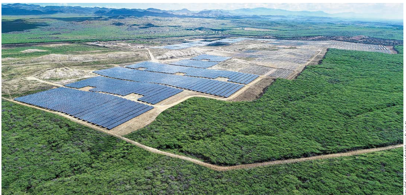
Park-Platz: Auf einem Areal von mehr als zwei Millionen Quadratmetern in der Dominikanischen Republik hat F&S solar concept aus Euskirchen einen gigantischen Solarpark installiert, der Strom für rund 50.000 Haushalte liefert.
