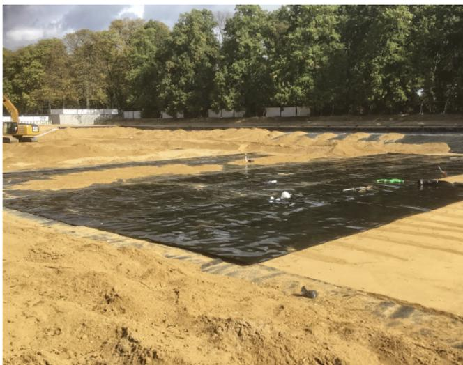
Verlegung der Kunststoffdichtungsbahn in breiten Bahnen
