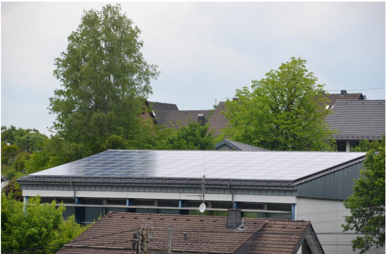
Turnhalle Schnellenbach, Dach mit Solaranlage
