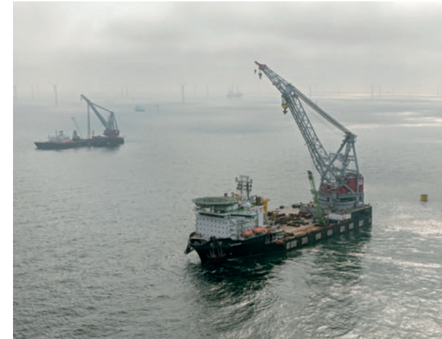
Trianel Windpark Borkum II: Setzen der Gründungsstrukturen Spezialschiff „Oleg Strashnov“
