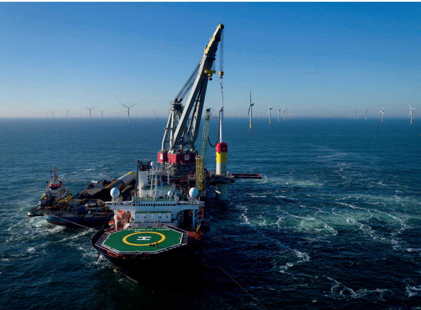
Trianel Windpark Borkum II: Erster Rammschlag BW 60, Spezialschiff „Stanislav Yudin“
