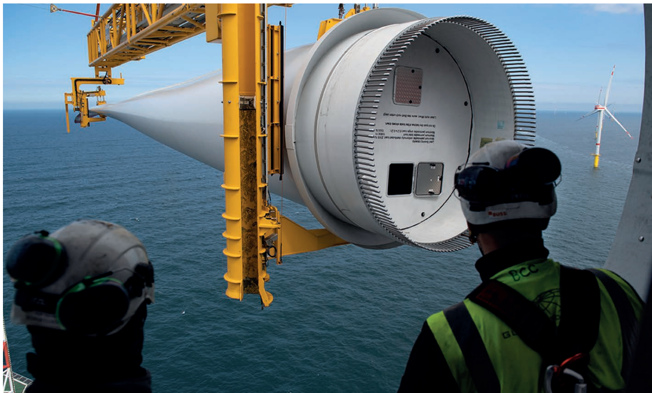
Montage des letzten Rotorblatts im Trianel Windpark Borkum II | Foto: © TWB II / Matthias Ibeler
