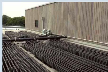
Abb. 36: Die Solarabsorberanlage auf dem Dach
