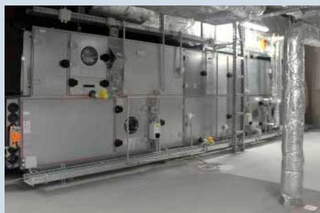
Abb. 34: Die zentrale Lüftungsanlage
