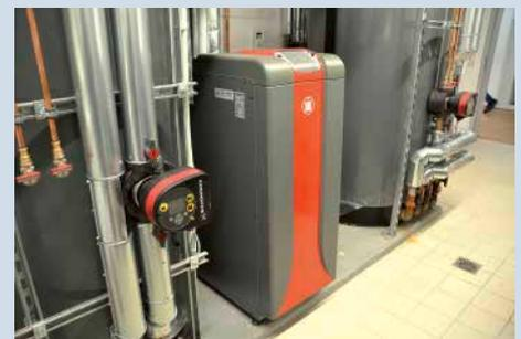
Abb. 72: Wärmepumpe und Schichtenspeicher
