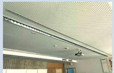
Abb. 48: Zuluft-Schlitzschienen in den Decken
