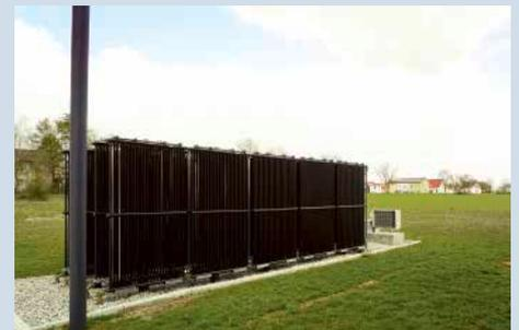
Abb. 60: Der Solar-Luftabsorberblock
