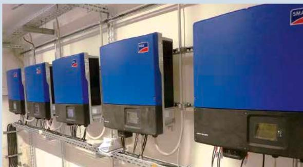
Abb. 93: Elektrische Wechselrichter mit Leistungsanzeige
