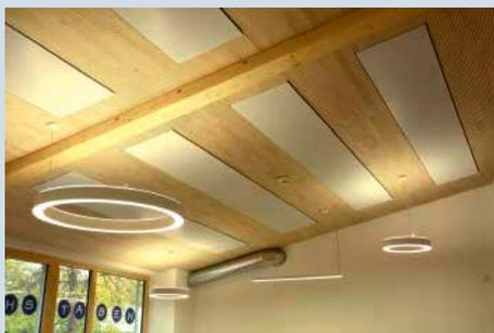
Abb.70: Integrierte Deckenheizung, LED-Leuchten
