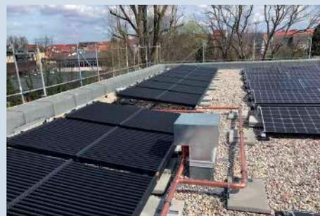
Abb. 13: Die Solarthermie-Anlage
