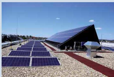
Abb. 23: PV-Anlage auf dem Dach des Neubaus
