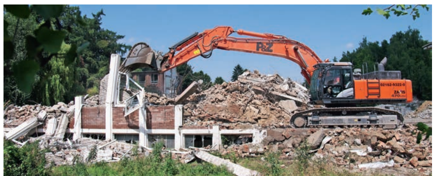
2016 wurde das Betriebsgebäude endgültig abgerissen.
