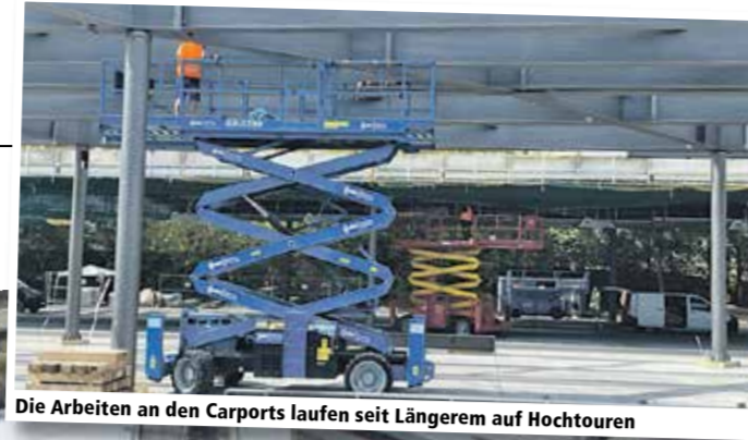
Die Arbeiten an den Carports laufen seit Längerem auf Hochtouren
