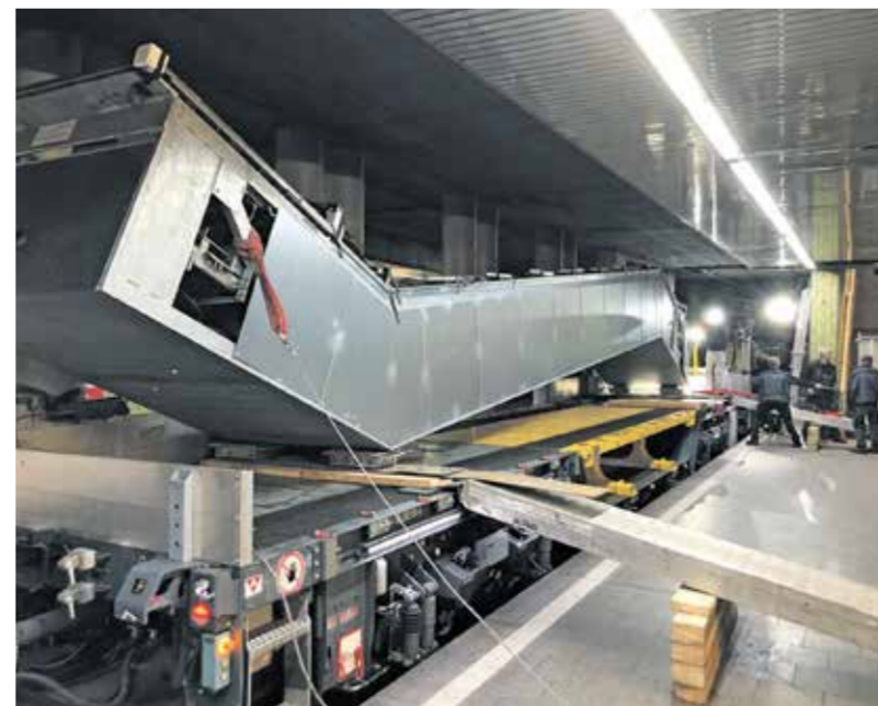
Der Transport der alten und neuen Rolltreppen erfolgt etwa mit Bauzügen der KVB über die Stadtbahnstrecken
