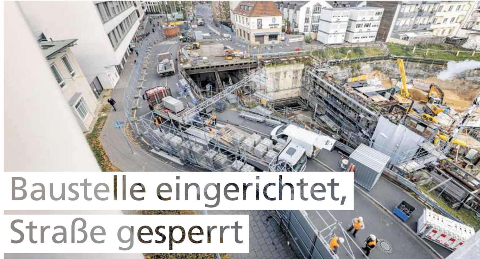
An der Baugrube am Waidmarkt kommt es wegen der Arbeiten rund ein Jahr lang zu Einschränkungen
