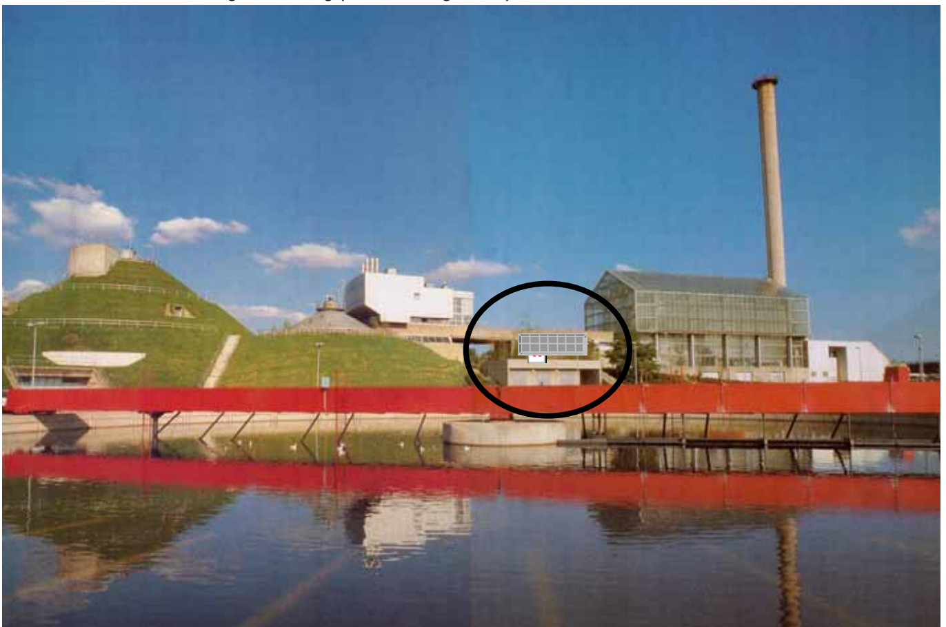
Zentrale Warte der Kläranlage Salierweg (schwarz eingekreist)
