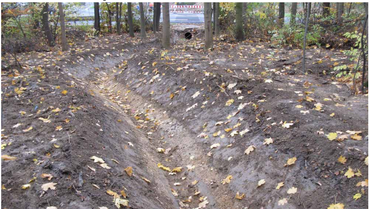
Neuer Bachlauf vor Verbindungsrohr zum Autobahnanschluss
