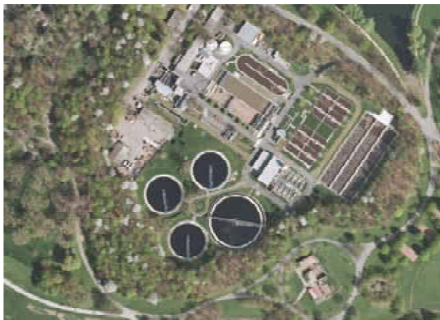
Kläranlage Bad Godesberg 2010
