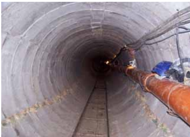
Stollen mit Betonfertigteile Nordseite
