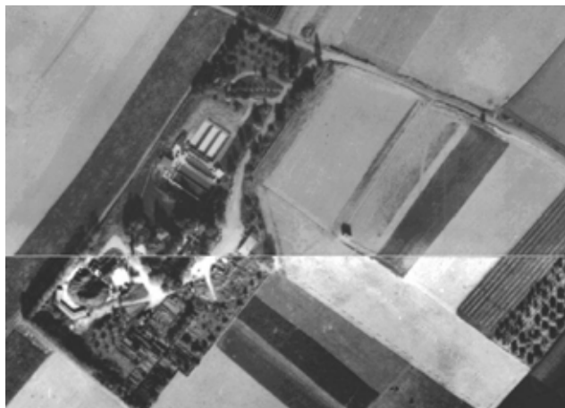
Kläranlage Bad Godesberg 1967
