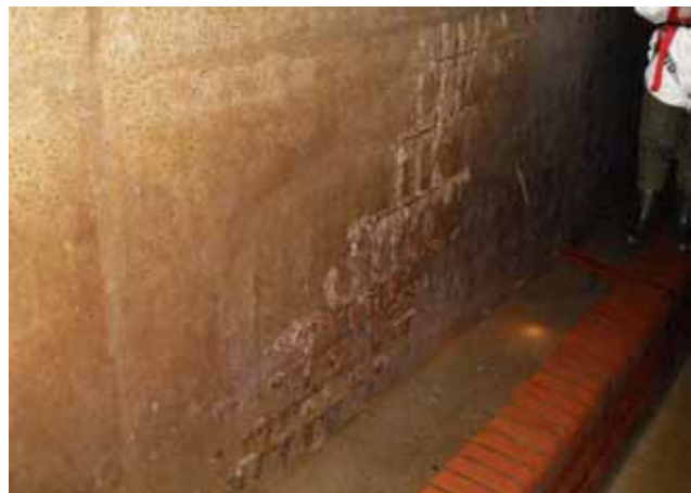
Korrosionsschäden
