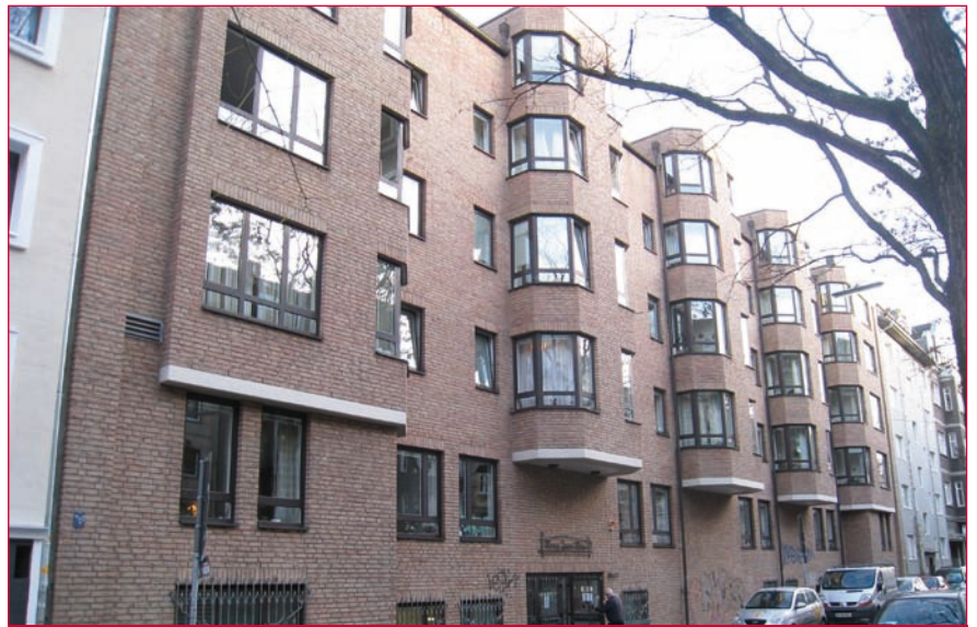
Blick auf das Gebäude an der Mainzer Straße
