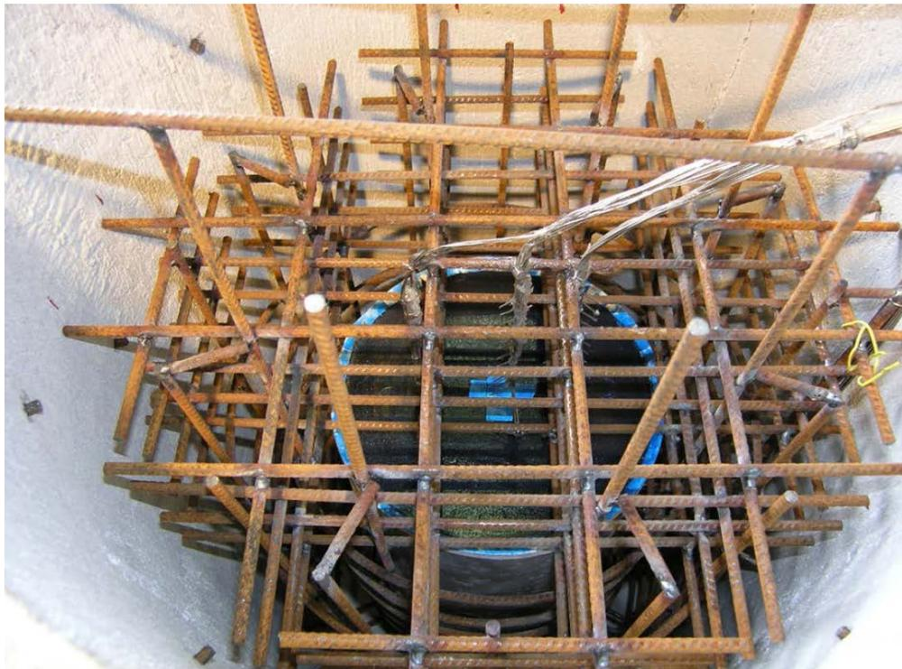
**Abb. 2.107** Ansicht der Armierung in Boden-/Seitenwänden des Tiegels vor dem Eingießen des Betons (Ansicht von unten). Bildquelle: KIT
