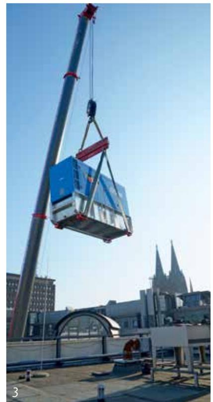
Blick in den Vorraum (1) und den Raum der Leitung des Notfallteams (2) im neuen Notfallzentrum der GRS. Zur Absicherung der Einsatzfähigkeit bei länger andauernden Netzausfällen verfügt das neue Notfallzentrum über eine unterbrechungsfreie Stromversorgung mit eigenem Notstromaggregat (in Bild 3 bei der Installation im Juli 2013) sowie über satellitengestützte Kommunikation.
