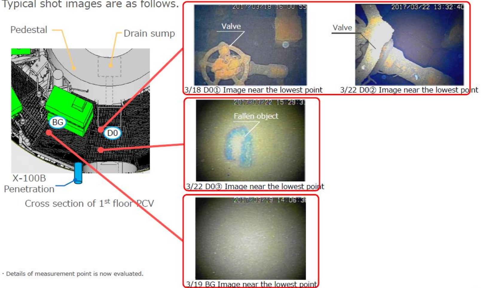
Abb. 3.10 Ergebnisse der visuellen Inspektionen im Ringbereich der Druckkammer um den Pedestal in Block 1 im März 2017, Orte ~160° fern der Öffnung zum Pedestal /TEP 17a/
