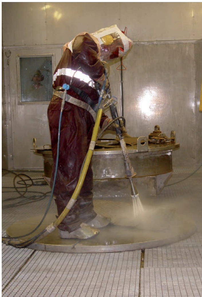
Abb. 24: Vollschutzausrüstung bei der Dekontamination mittels Hochdruckreiniger
