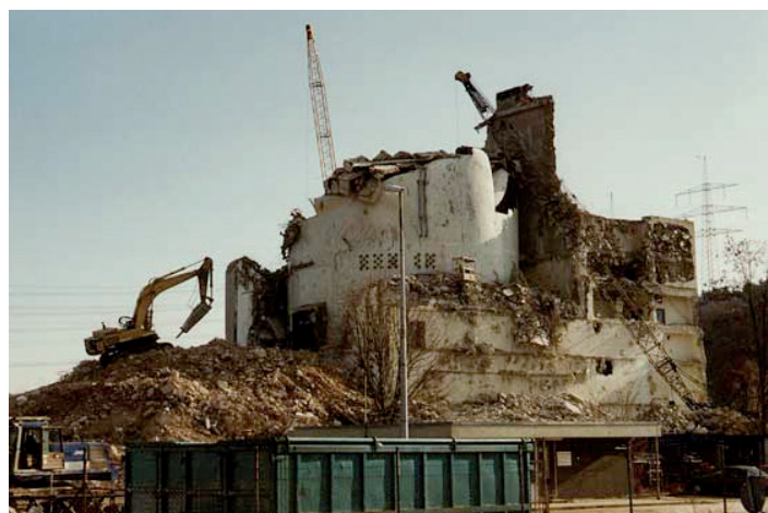
Abb. 17: Konventioneller Abriss der äußeren Gebäudehülle des Kernkraftwerks Niederaichbach
