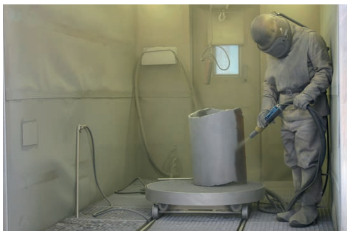
Abb. 16: Dekontamination mittels Sandstrahlen
