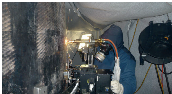
Abb. 28: Manueller Einsatz thermischer Zerlegetechniken
