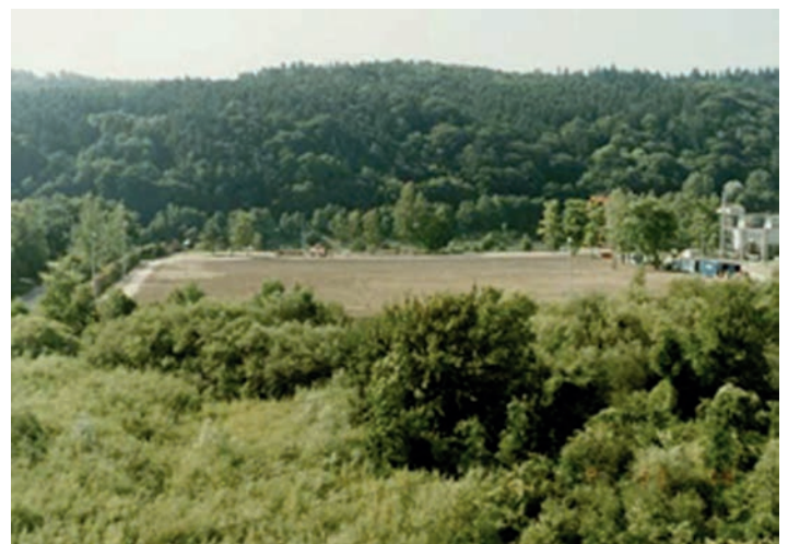
Abb. 1: Rückbau des Kernkraftwerks Niederaichbach
