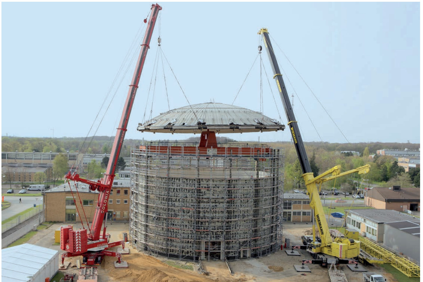
Abb. 7: Abbau des Forschungsreaktors FRJ-1
