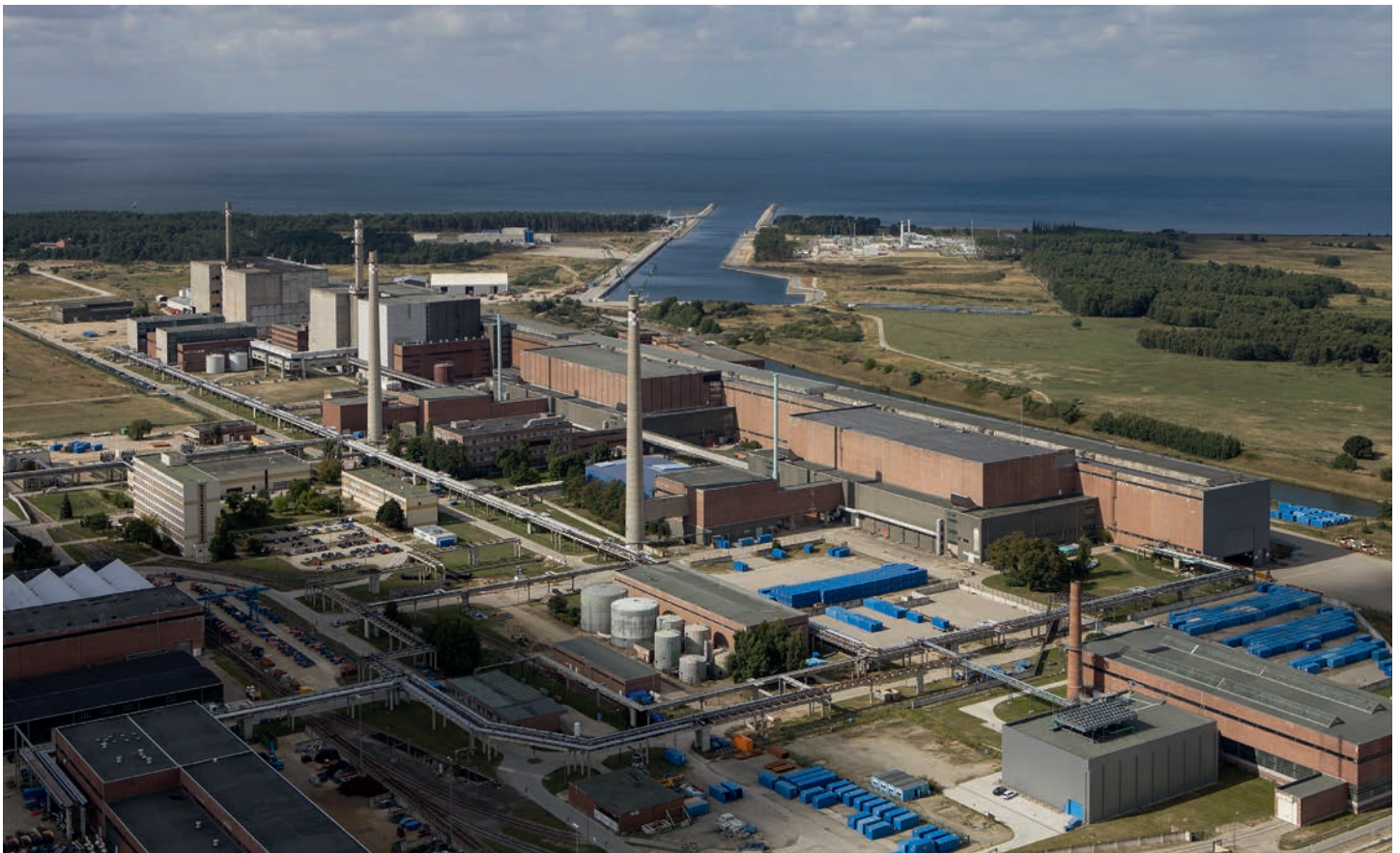
Abb. 2: Standort des Kernkraftwerks Greifswald
