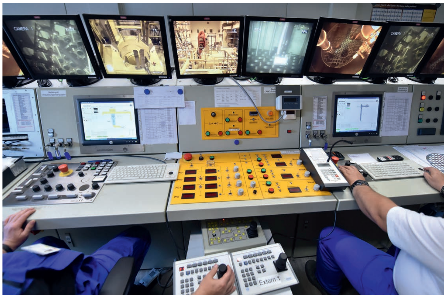
Abb. 44: Leitstand zur fernbedienten Zerlegung im Kernkraftwerk Obrigheim
