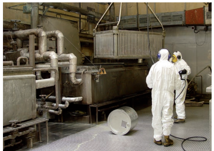
Abb. 25: Chemische Dekontamination
