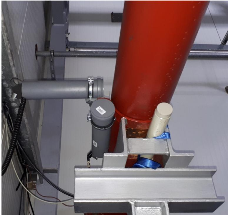
**Abb. 6.157** Einbaulage und Positionierung der Detektoren an der Reinjektionsleitung der Anlage Insheim. In den dunkelgrauen Rohren: NaJ-Detektoren
