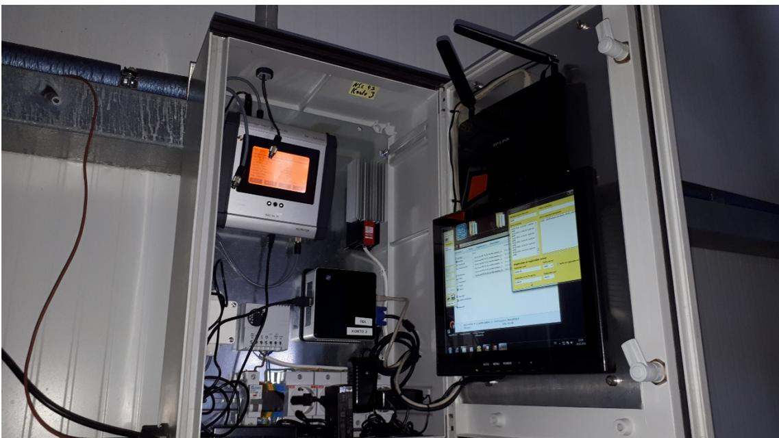
**Abb. 6.156** Innenansicht Messschrank Konto 3 mit 4G/LTE Router
