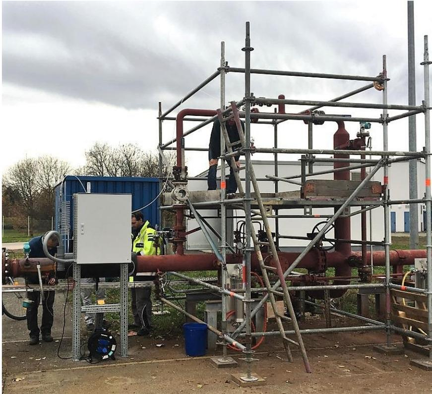
**Abb. 6.77** Montage der Messstation auf dem Trägergestell und Anschluss der Anlage an die Gasbrücke
