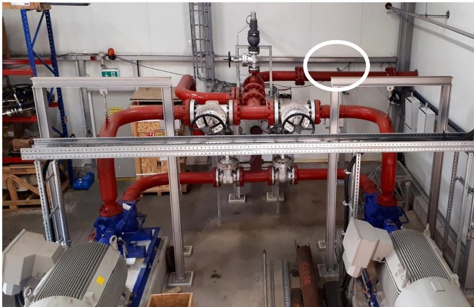
**Abb. 6.154** Bereich der ODL-Installation an der Reinjektionsleitung im Geothermiekraftwerk Insheim. Einkreist ist die Position der Detektoren
