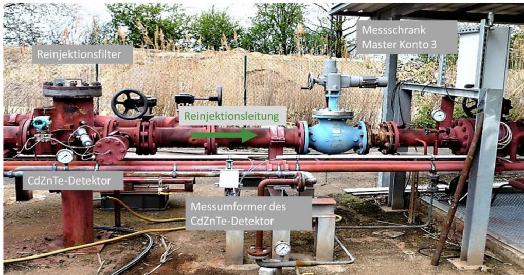
**Abb. 6.152** Instrumentierung Konto 3 Reinjektionsleitung
