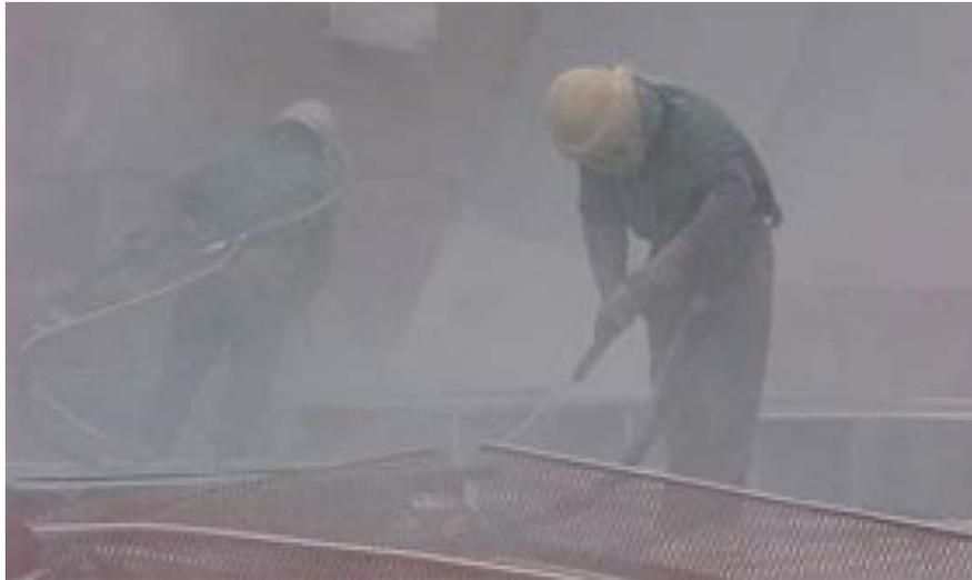
**Abb. 6.167** Trockenstrahlverfahren im Einsatz /OCC 14/
