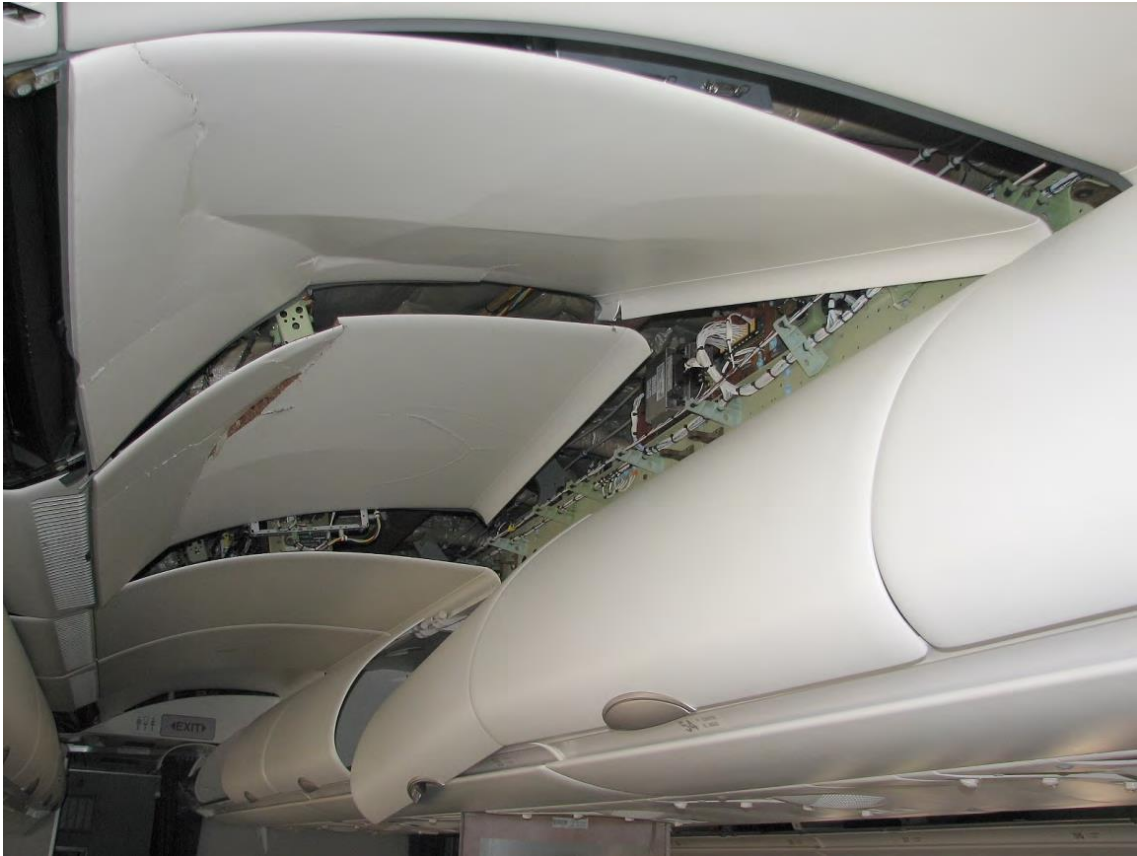
Abb. 7.7 Foto eines Teils der Schäden, die an der Decke des Passagierraums über dem Gang entstanden sind /ATS 11/
