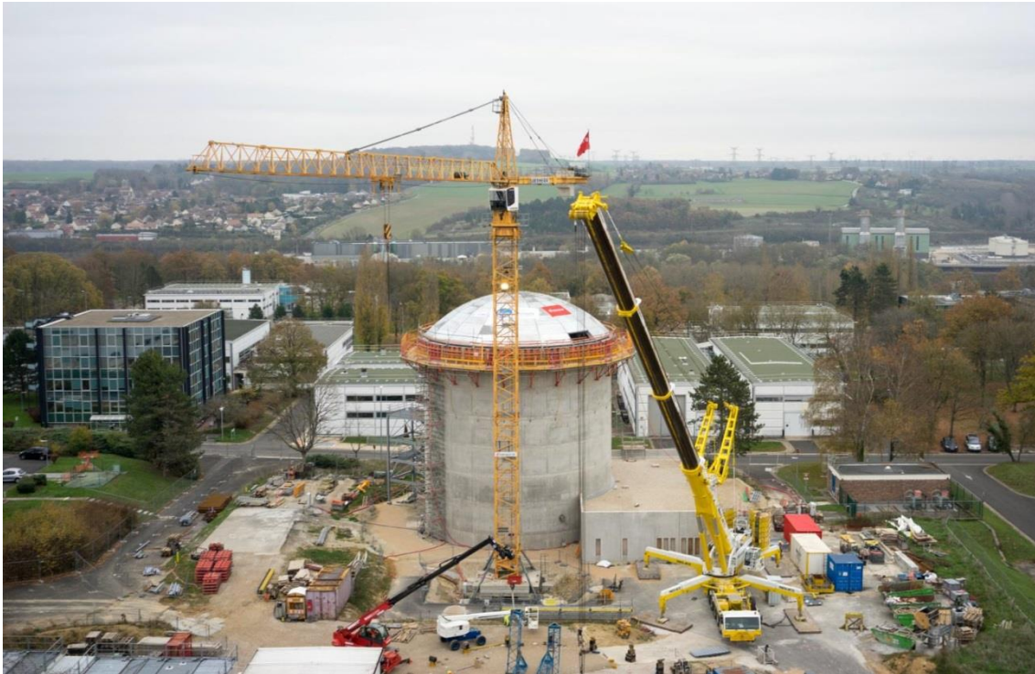
Abb. 4.8 VeRCoRs Containment-Modell im Maßstab 1:3 zu einem realen Containment auf dem EDF Forschungsgelände Les Renardières bei Paris, Frankreich /COR 16/
