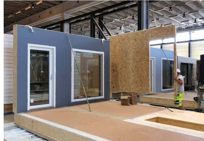
Werksbesichtigung Sisco Oyj: Zusammenbau eines Raummoduls
