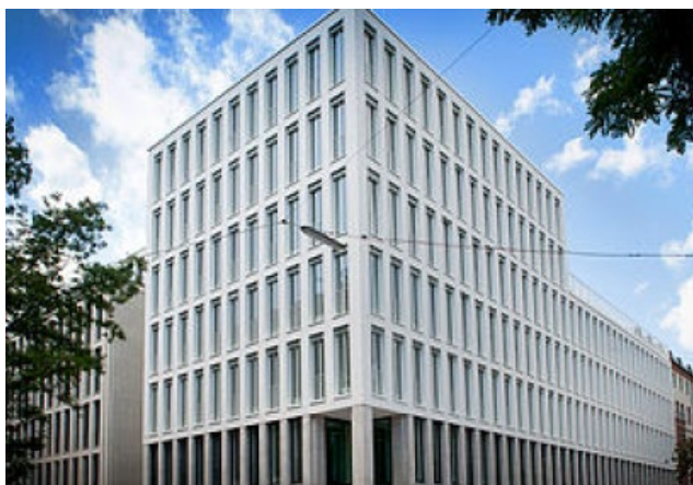
Abbildung 37: Foto der Südost- und Nordostfassade des Büro-Mustergebäudes (Quelle: Energieausweis)
