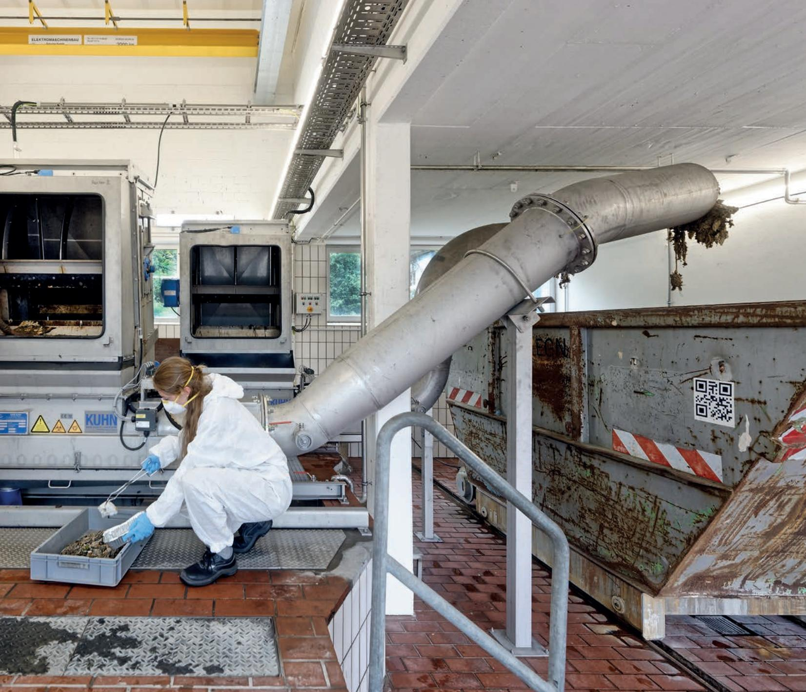
Bild 1: Beprobung von Feststoffen am Rechen einer Kläranlage
