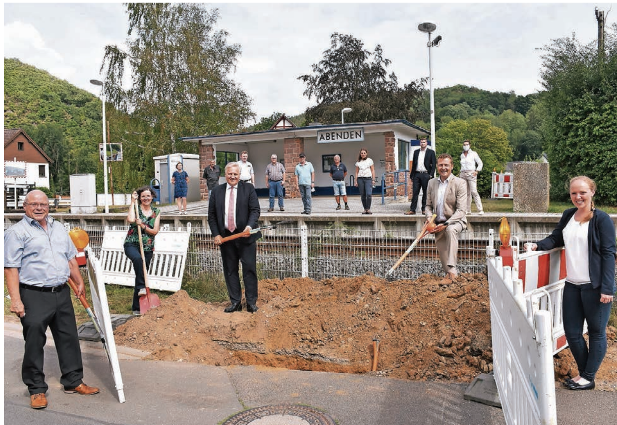
Mitte August 2020 begannen die Arbeiten zum Lückenschluss des Breitbandnetzes in Abenden. Foto: Kreis Düren
