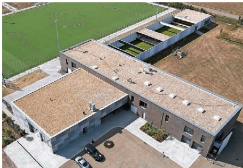
So sieht das Bürgerwaldzentrum in Morschenich-Neu von oben aus.
