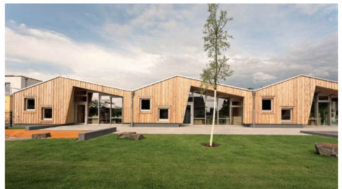
Bonn – Kita in elementierter Holzbauweise (Foto Patrik Prior)
