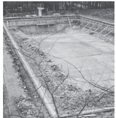
SA Schleiden, Bildsammlung: Instandsetzungsarbeiten am Schwimmbad in Gemünd, 1975. Das heutige „Rosenbad“ stammt von 1936. Der Drei-Meter-Turm trägt die Olympischen Ringe aus. (© Heinz Naumann)
