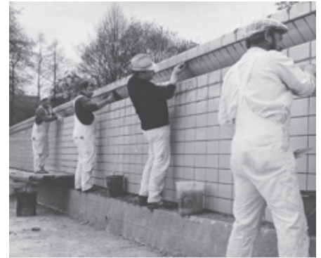
Verkleidungsarbeiten am Schwimmbad in Gemünd, 1975. Das Becken erhält frischblaue Kacheln. (© Heinz Naumann)
