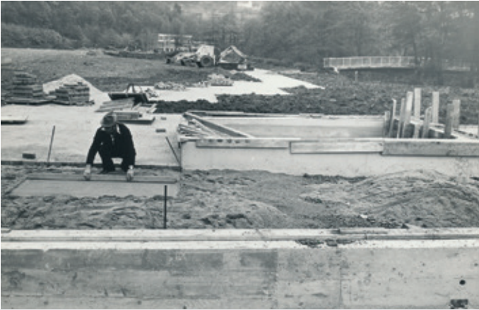
SA Schleiden, Bildsammlung: Ausbau- und Neubauarbeiten im Kurpark Gemünd, 1977. (© Heinz Naumann)
