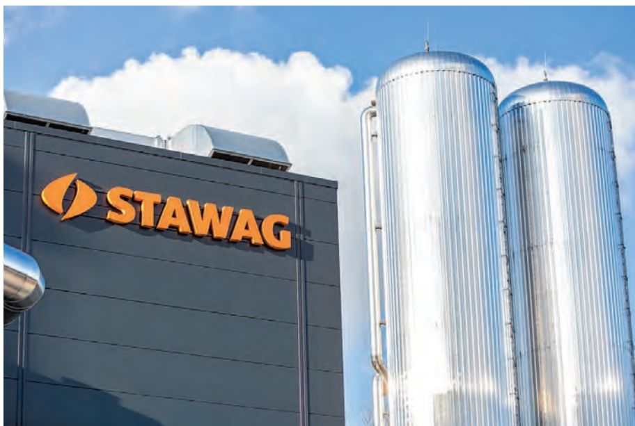
Ende 2018 hat die STAWAG das größte Blockheizkraftwerk in Aachen am Campus Melaten der RWTH in Betrieb genommen. Trianel ermittelt dafür die wirtschaftlich optimale Fahrweise.
