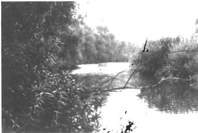
Abb. 7: Trotz fehlender Unterhaltung und Beeinträchtigungen durch Weidevieh erfüllte die naturnahe Ufersicherung an der Nahe über drei Jahrzehnte die ihr gestellte Aufgabe. Stellenweise finden sich in den offenen Buchten bereits Arten einjähriger Spülsäume und in den Bereichen der Weich- und Hartholzauze Feuchtezeiger und Auwaldarten. Dringend erforderlich ist, das Weidevieh aus dem Ufergehölz herauszuhalten. (Foto: W. Pflug)
