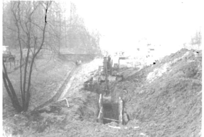
Bild 3: Bau des Abfangsammlers (Foto: Stecker)
