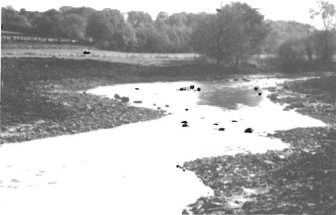
Abb. 5: Dieselbe Strecke wie in Abb. 4 vor Abschluß der Sanierung. Es ist ein breites, flaches und naturgemäß gekrümmtes Bachbett mit buchtenreichen Flachufern und einer naturgemäßen Abfolge aus schnell und langsam fließenden Abschnitten entstanden. Sohle und Mittelwasserufer sind wegen des notwendigen Erosionsschutzes (Sohlgefälle 3 Promille) und zur vorteilhaften Biotopgestaltung mit Naturschüttstein (5 — 40 cm) vorstrukturiert. (Foto: Otto)
