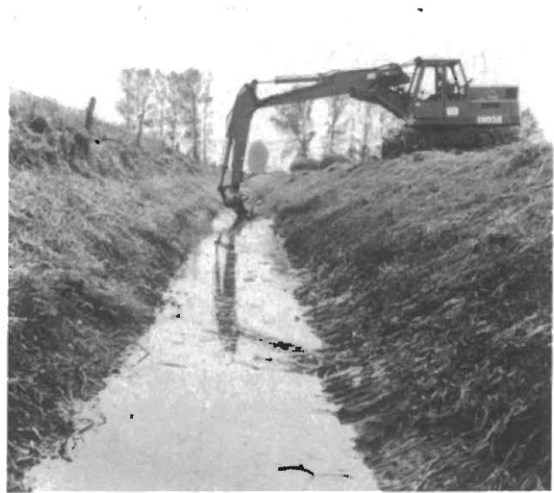
Foto 2: Blick auf dieselbe Untersuchungsstrecke während der Räumung durch den Mähkorb. (Foto: Menze)
