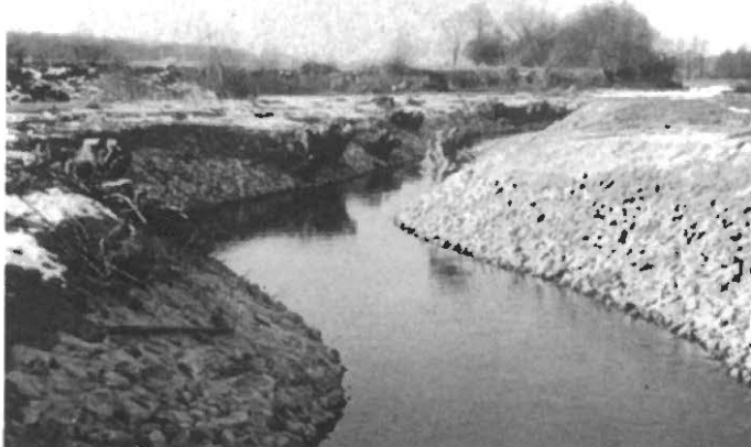
Bild 1: Gewässer durch Unterhaltungsmaßnahmen naturfern verändert (Foto: Foschepoth)
