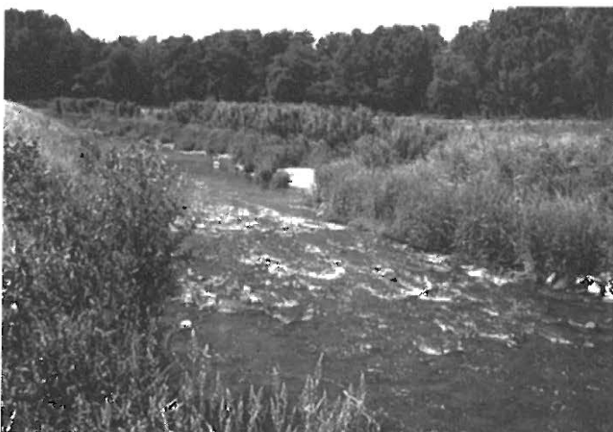
Abb. 4: Bocholter Aa bei Haus Pröbsting. Sohlabsturz zu Sohlgleite umgebaut. (Foto: Schoof)
