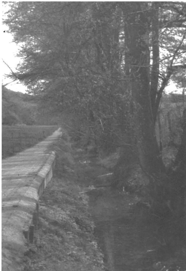
Ein befestigter Wanderweg nach Rodung der Erlen ist kein Vorbild für die Erholungsnutzung von Uferstreifen! (Foto: Bauer)
