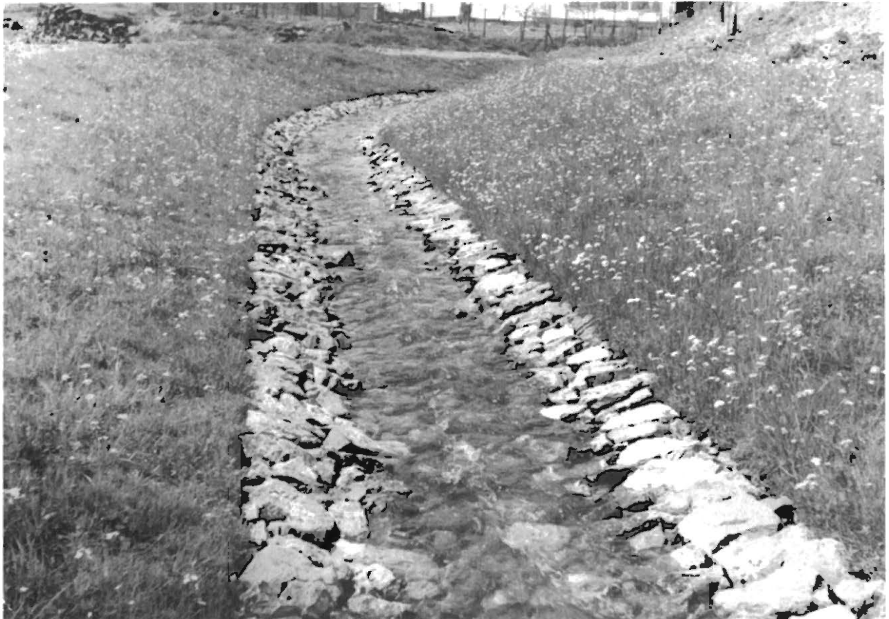
Ausgebauter Bachlauf in der Eifel, dessen Führung hätte naturnaher sein müssen. Die Sohle des Wasserlaufs und der Böschungsfuß sind erfreulicherweise mit Natursteinpflaster befestigt, an das sich der Rasen unmittelbar anschließt. (Foto: Olschowy)
