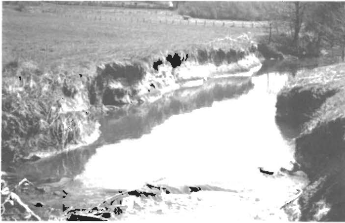
Abb. 4: Der Holzbach bei Dierdorf vor der Sanierung (1985). Hier wurde 1939 eine Laufbegradigung ohne Sohlenbefestigung durchgeführt (Sohlgefälle 3 Promille!). Die Tiefe und Breite des Bachbettes haben sich seither durch Erosion verdreifacht. Der überdehnte Mittelwasserkörper ist bis zu 2 m tief, extrem strömungsarm und an der Sohle stark verschlammmt. Der Bach ist als Folge der Erosion und der Verschlämzung im Ufer- und Sohlbereich verödet und auch als Fischbiotop entartet. (Foto: Otto)
