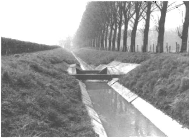
Bild 2: Dellwiger Bach vor der naturnahen Umgestaltung (Foto: Stecker)
