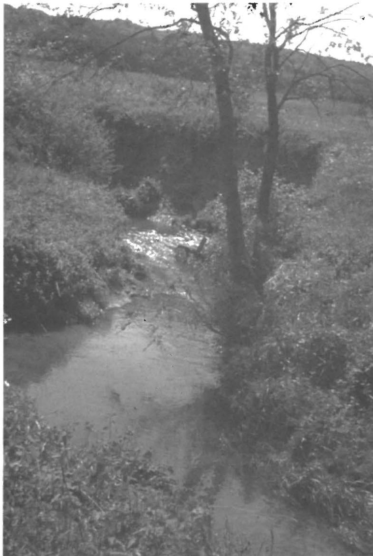
Erodiertes Ufer einer Talwiese; bei Ausweisung eines Uferstreifens kann die Erosion geduldet werden. (Foto: Bauer)
