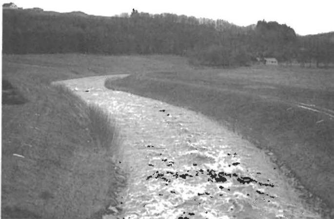
Abb. 4: Flußbett 1978, zwei Jahre nach Ausbau.
