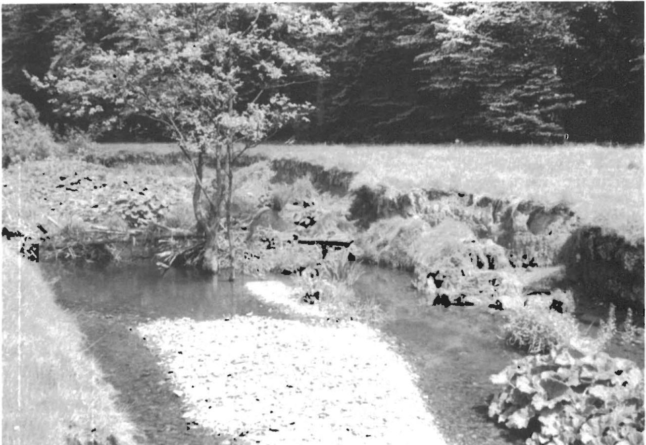
Die Außenufer der Wasserläufe werden bei Hochwasser besonders belastet, was zu erheblichen Abtragsschäden führt, wenn eine geschlossene uferschützende Bepflanzung fehlt. Einzelstehende Bäume können den Schaden noch vergrößern. (Foto: Olschowy)
