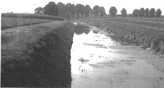
Abb. 1: Technisch ausgebaute Issel. (Foto: Schoof)
