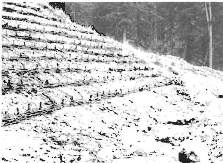
Ein durch den Ausbau der Straße angeschnittener Hang muß hier mit Hilfe von Faschinen befestigt werden, um einen weiteren Bodenabtrag zu verhindern und eine Wiederbepflanzung zu ermöglichen. Foto: G. Olschow
