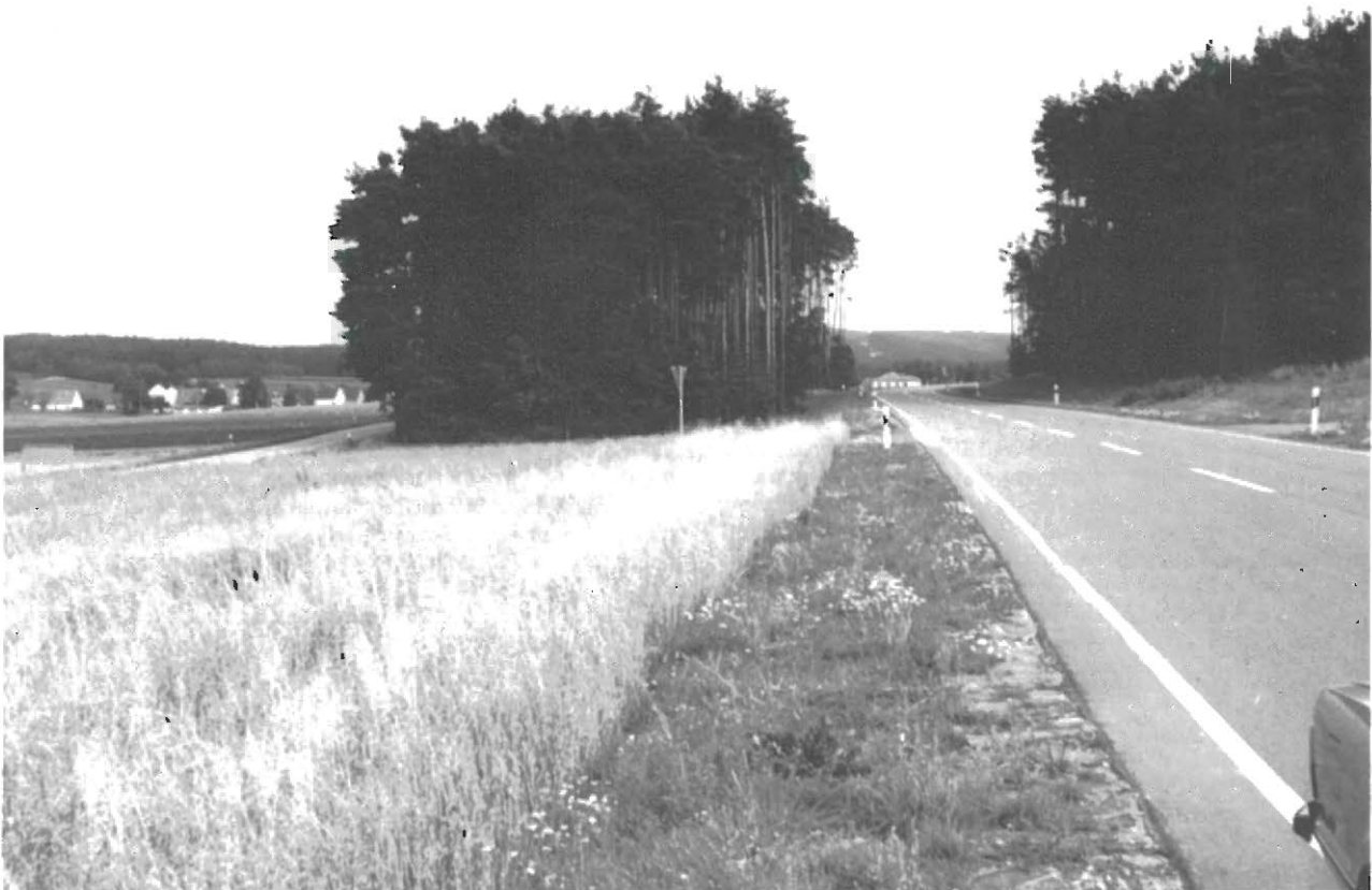
Anstatt die neue Straße am Waldrand vorbeizuführen, wo auch die alte Straße verlaufen ist, wurde unverständlicherweise der Wald durchschnitten und damit ein vermeidbarer Eingriff vorgenommen (vgl. auch Abschnitt 8 der Stellungnahme des Deutschen Rates für Landespflege, S.884).
