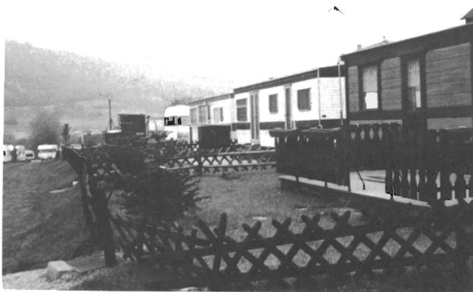
Ein Stellplatz bzw. Campingplatz im südlichen Bereich des Naturparks Südeifel. An jedem abgestellten Wohnwagen ist ein stationäres Wohnhaus, z. T. noch mit Terrasse, angebaut, ohne daß ein Bebauungsplan bzw. eine Baugenehmigung vorliegt.
