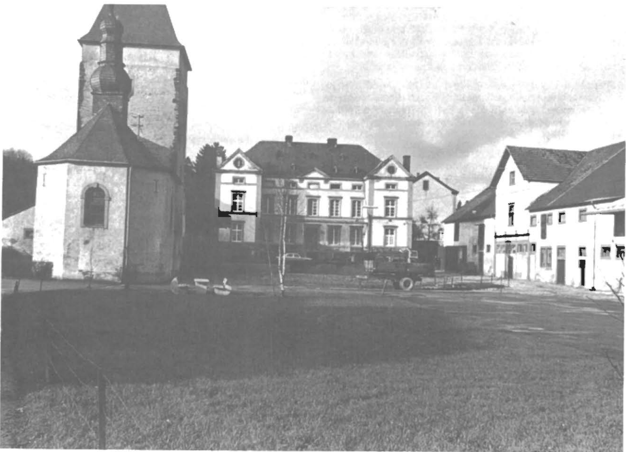
Schloßartiger Gutshof in Niedersgegen im Gaybachtal. Die Kapelle von 1734, der starke mittelalterliche Wohnturm, das Gutshaus und das Stallgebäude bilden zusammen eine malerische Gebäudegruppe.
