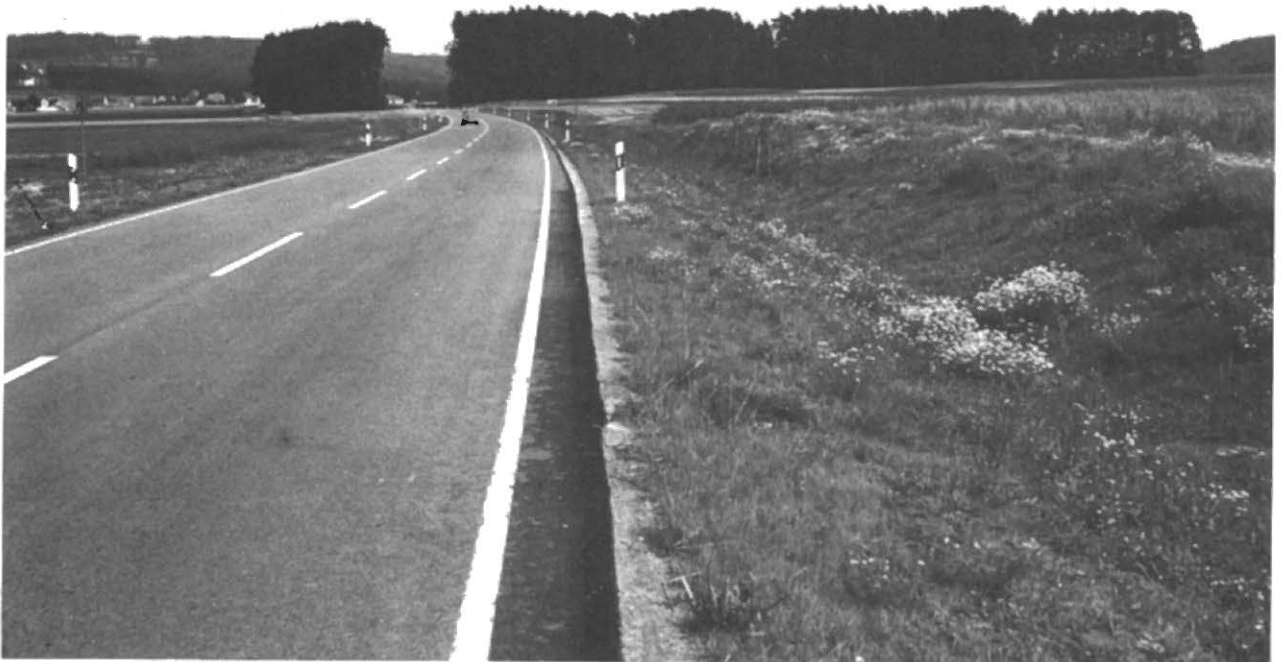
Anstatt die neue Straße am Wald vorbeizuführen, wo die alte Straße verlaufen ist, wurde unverständlicherweise der Wald durchschnitten und damit ein vermeidbarer Eingriff vorgenommen.
