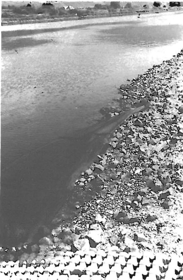
Abb. 4 Uferschäden durch Wellenbelastung im Übergangsbereich verschiedener Deckwerke (1977)
