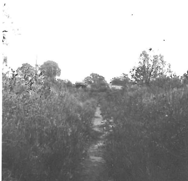
Abb. 1 „Möllers Kanälchen“, 1. Vegetationsperiode. Neu hergerichtetes Trapezprofil mit einer Steinschüttung, die die Gewässersohle überzieht und etwas über den Mittelwasserbereich hinaufreicht. Die im Anschluß daran gepflanzten Schwarzerlen (Pflanzgut 80/100 cm) überragen den wüchsigen Böschungsrasen. 20. Mai 1974.
