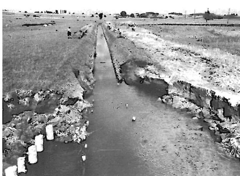
Abb. 11 Hinter Brückendurchlässen, die zu eng bemessen sind, treten bei Hochwasser häufig Kolk­schäden an beiden Ufern auf. (Foto: Olschowy)
