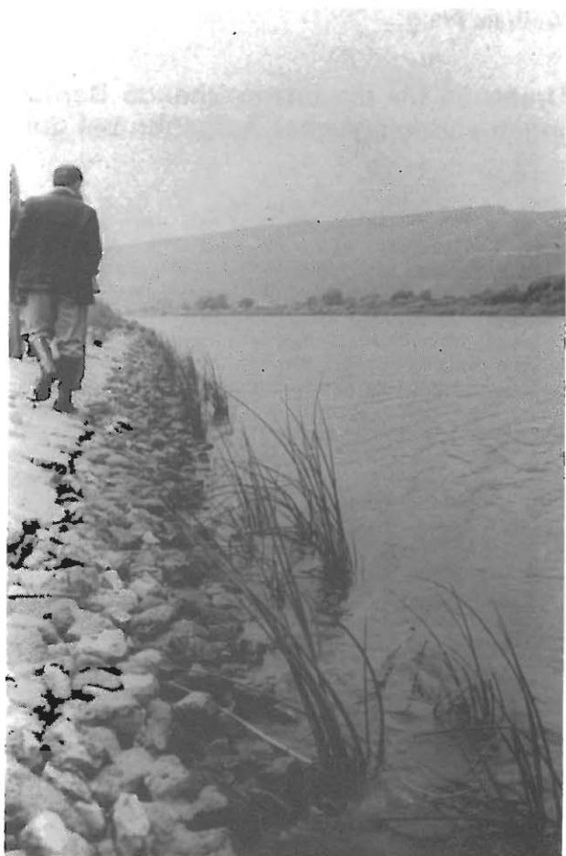
Abb. 7 Flechtbinsen im mit Asphalt-Mastix verklammerten Schüttsteindeckwerk (1977)
