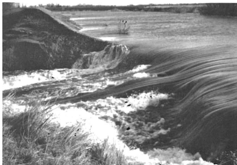
Abb. 13: Zerstörte Strandmauer am Nordstrand von Norderney nach der Februarsturmflut 1962
