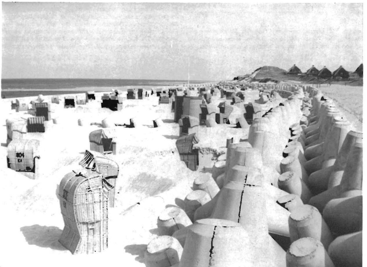
Abb. 29: Badestrand bei Hörnum. Die Tetrapodenreihe dient der Sicherung der Insel – insbesondere der Wohnhäuser im Hintergrund – gegen Sturmfluten
