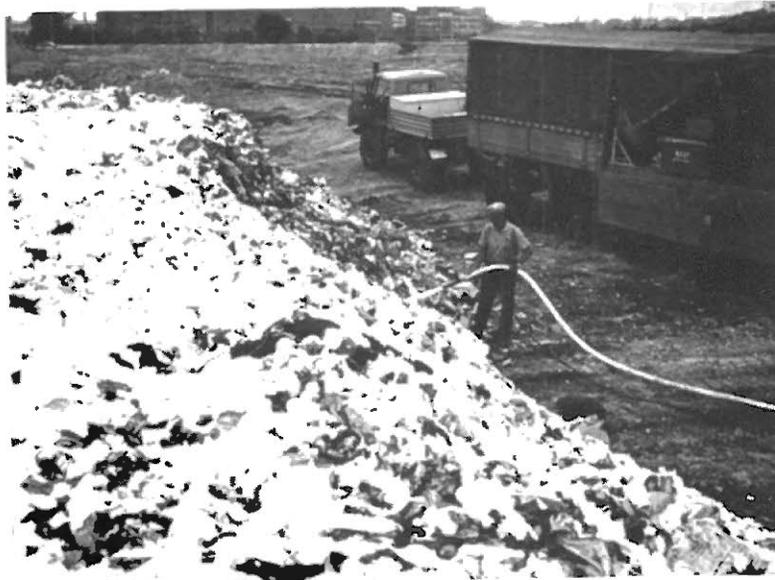
Abb. 23: Abdeckung einer Abfalldeponie mit Harzschaumstoff. Mit einem auf der Ladepritsche eines Fahrzeugs installierten Gerät wird der Schaum an Ort und Stelle erzeugt und über eine Schlauchleitung aufgetragen
