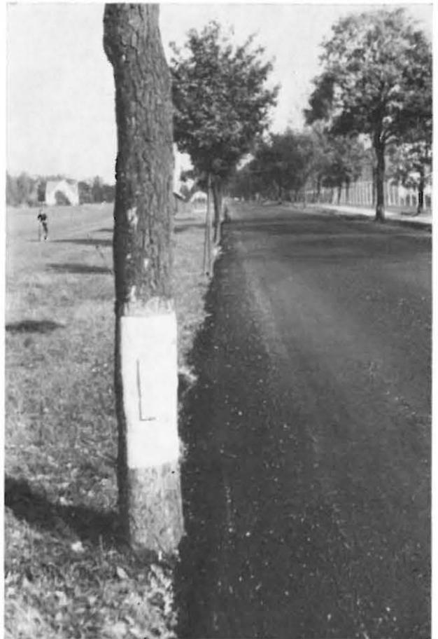
Abb. 9: Die befestigte Fahrbahn ist verbreitert worden, so daß jetzt die Straßenbäume unmittelbar am Fahrbahnrand zu stehen kommen.
