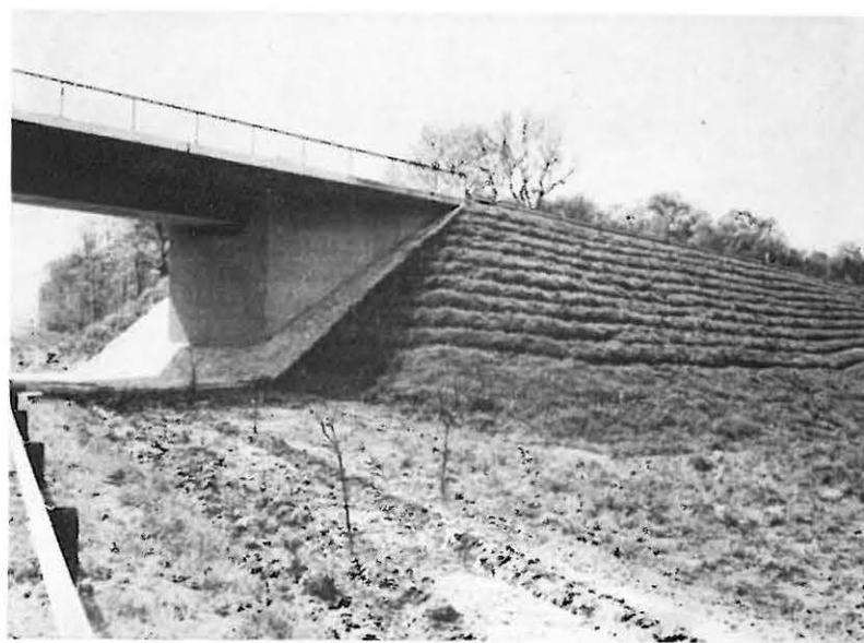
Abb. 8: Eine Böschungsfläche an einem Brückenanschluß der Autobahn bei Freiburg, die vorbildlich mit Hilfe von Riefen bepflanzt worden ist.
