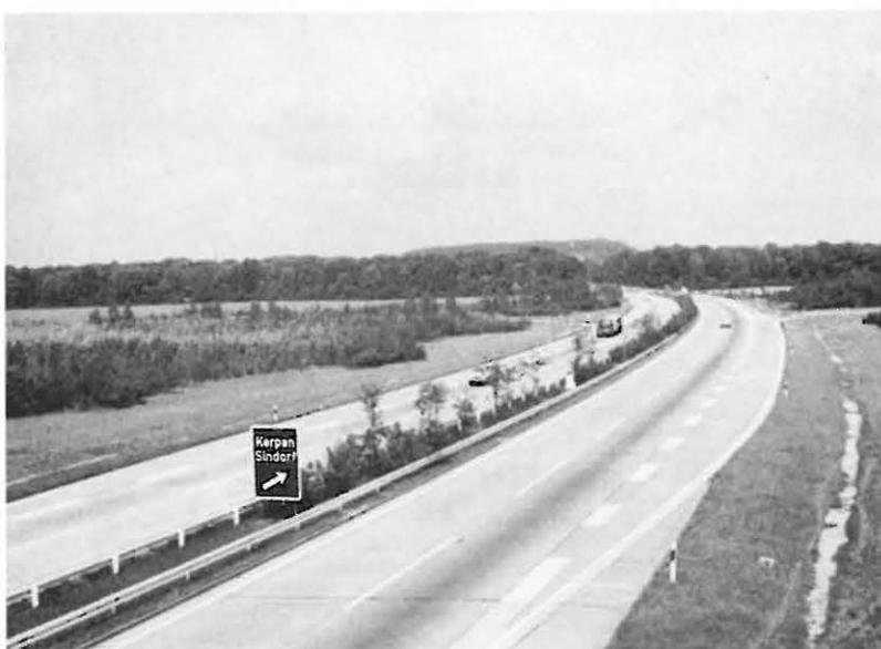
Abb. 5: Der Mittelstreifen der Autobahn Köln–Aachen ist hier mit langgestreckten Gehölzgruppen ausreichend bepflanzt, so daß er die Aufgabe des Blendschutzes übernehmen kann und ein Beobachten des Fahrgeschehens auf der Gegenfahrbahn ermöglicht.
