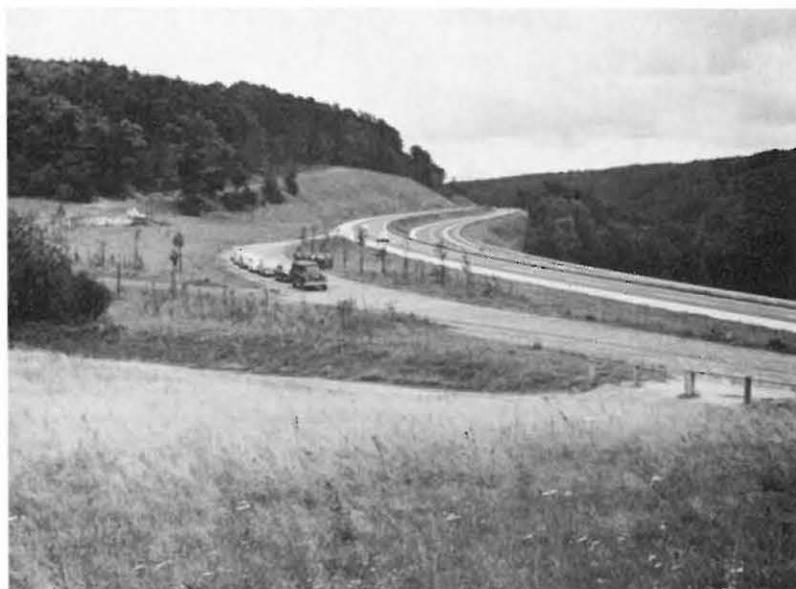
Abb. 6: Die an den Hang angelehnte Autobahn im Spessart erlaubt es, die Richtungsfahrbahnen mit Niveauunterschied auszubauen, so daß hier sowohl die Gefahr der Blendwirkung als auch des Überfahrens ausgeschlossen ist.
