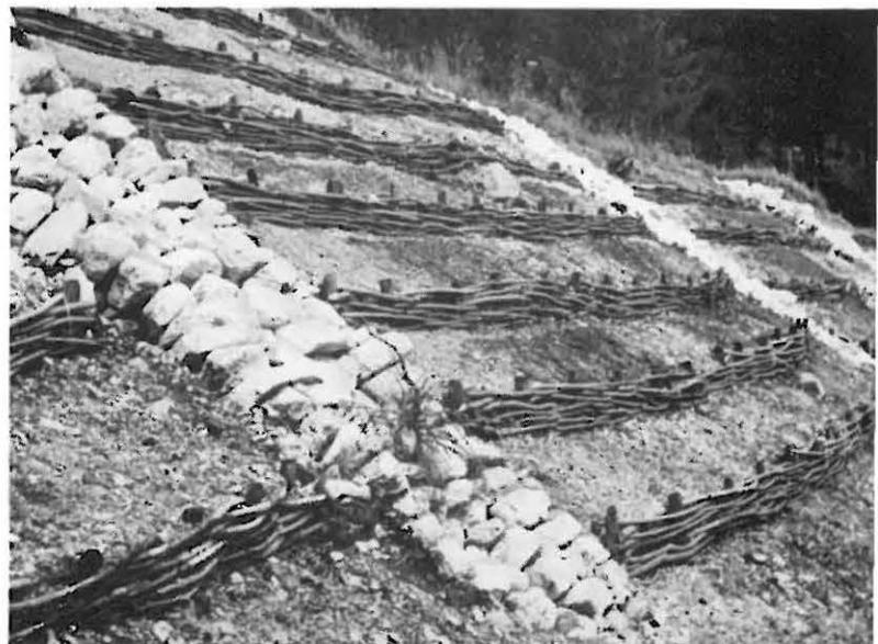
Abb. 10: Eine Straßenböschung, die mit einem Horizontalgeflecht befestigt ist und mit einer Steindränung entwässert wird. Die Flächen zwischen dem Flechtwerk werden mit Feinboden ausgefüllt und bepflanzt.
