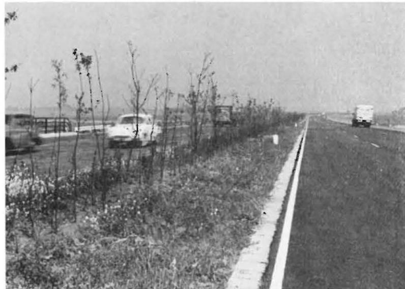
Abb. 7: Ein dicht und durchgehend mit Bäumen und Sträuchern beplanter Mittelstreifen einer Autobahn, der die Richtungsfahrbahnen optisch völlig voneinander trennt.
