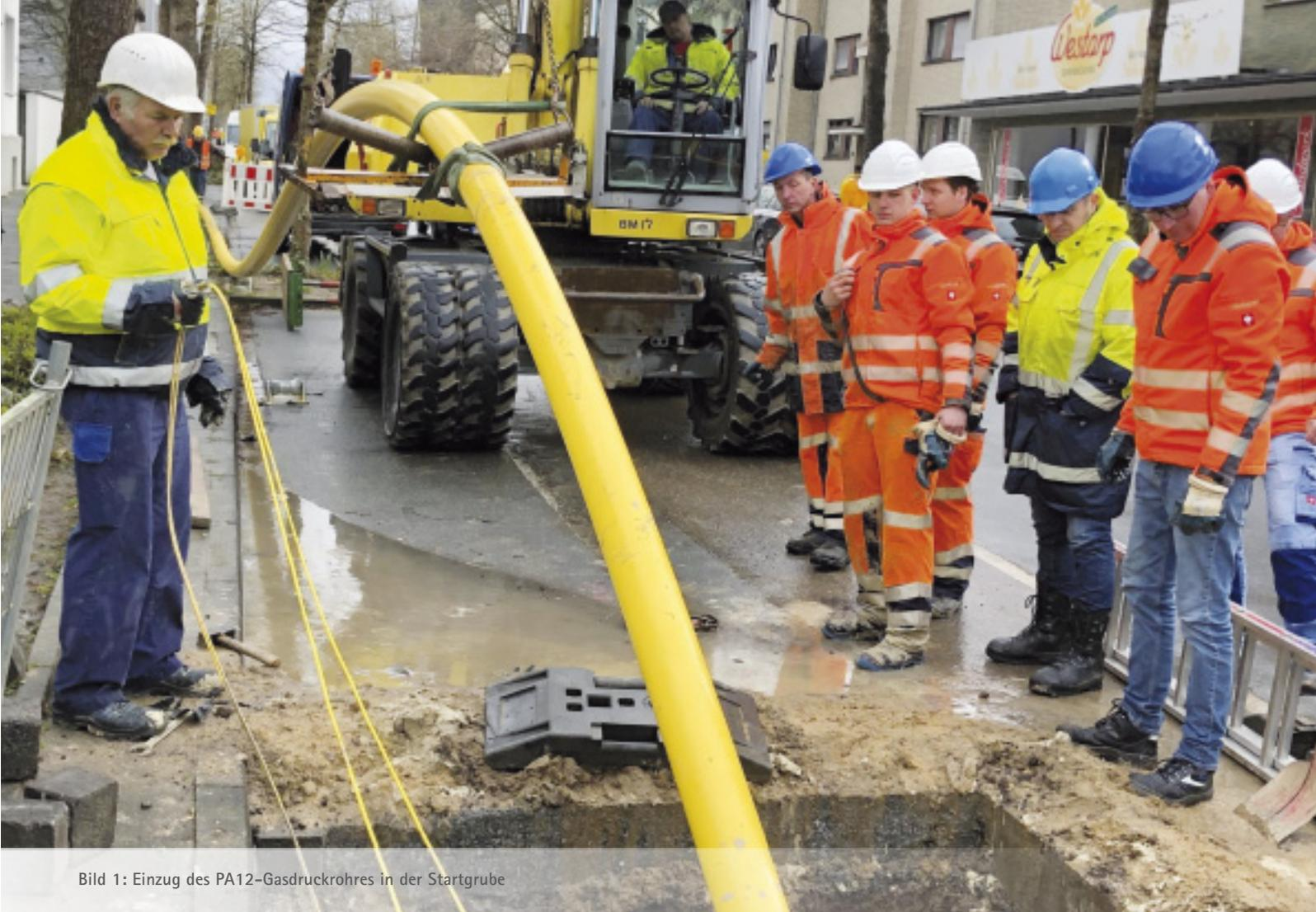
Bild 1: Einzug des PA12-Gasdruckrohres in der Startgrube
