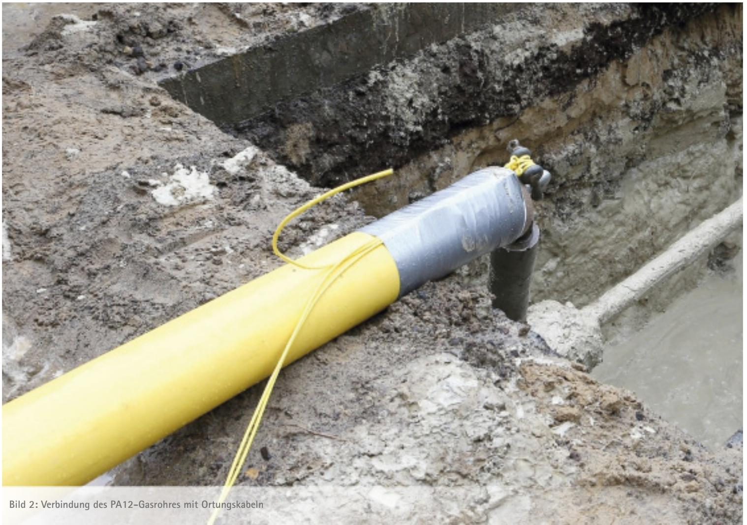
Bild 2: Verbindung des PA12-Gasrohres mit Ortungskabeln
