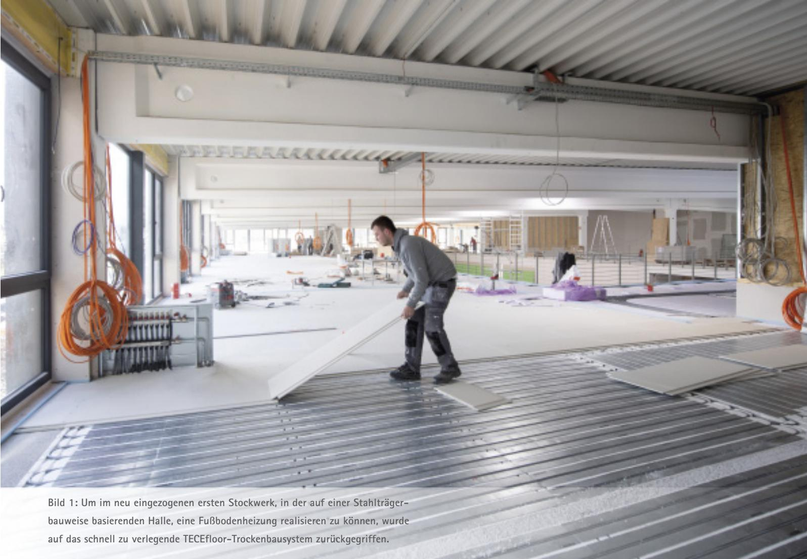
Bild 1: Um im neu eingezogenen ersten Stockwerk, in der auf einer Stahlträgerbauweise basierenden Halle, eine Fußbodenheizung realisieren zu können, wurde auf das schnell zu verlegende TECEfloor-Trockenbausystem zurückgegriffen.
