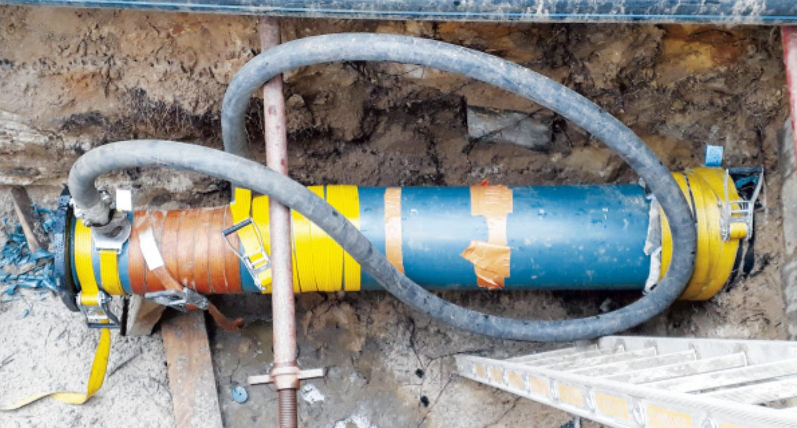
Bild 4: Compact Pipe® im Baugrubenbereich während der Rückverformung.
