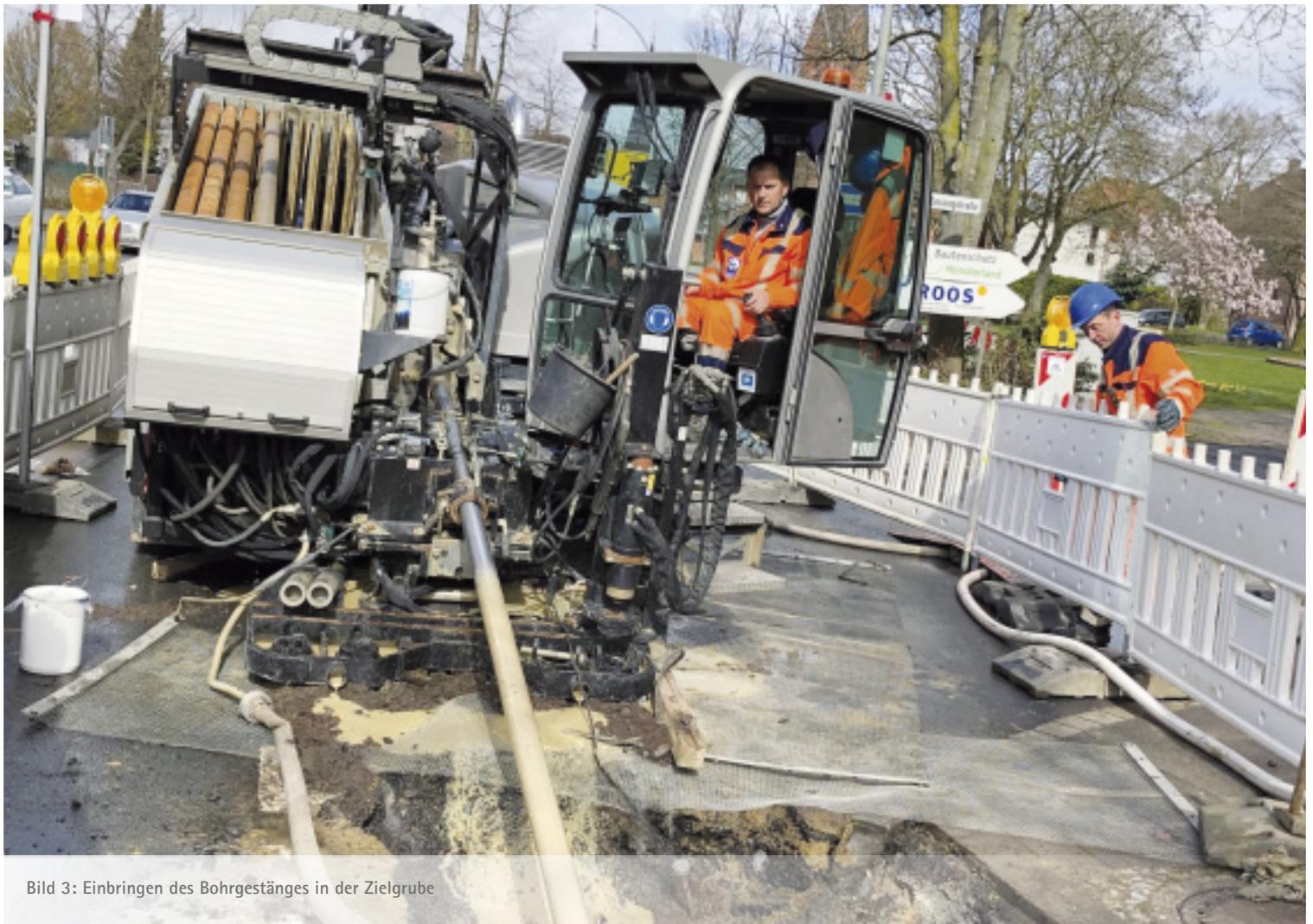
Bild 3: Einbringen des Bohrgestänges in der Zielgrube
