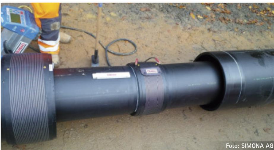
Bild 4: Verschweißen der Rohre mit dem Kaskadenschweißverfahren
