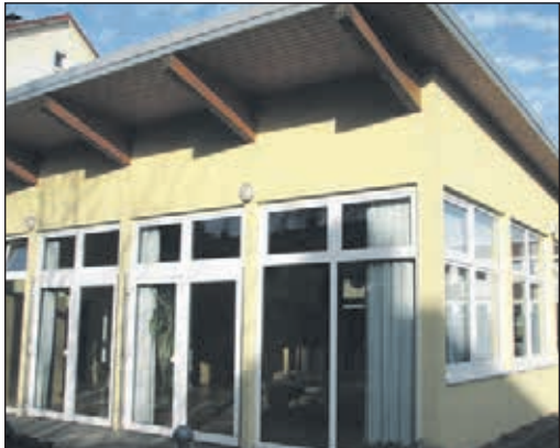
Die umgebaute Mehrzweckhalle Foto: team x
