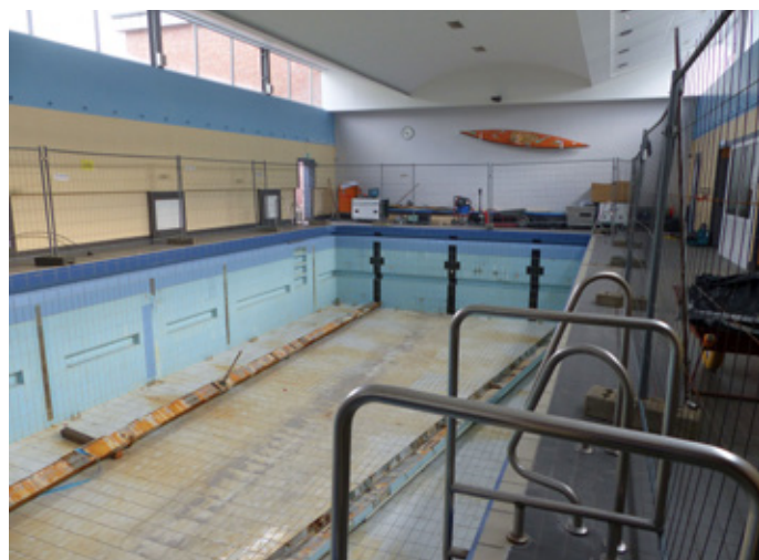
Der Hubboden des Dolphibades wurde bereits entfernt. Die Schadstoff- und Betonsanierung soll im nächsten Arbeitsschritt folgen. Foto: C. Buchen
