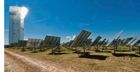
Solarturm DLR Jülich
