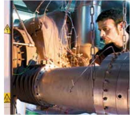
Hybridkraftwerk mit hohem Wirkungsgrad durch die Kopplung einer Gasturbine mit einem Hochtemperaturbrennstoffzellensystem
