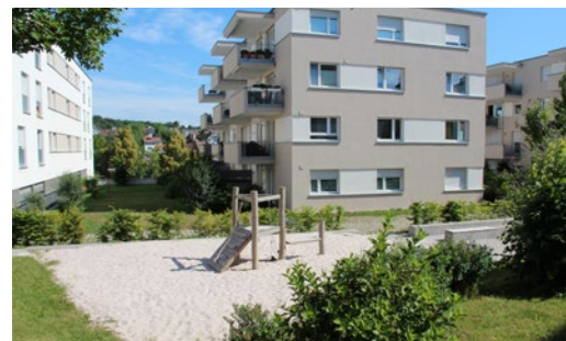
Punkthäuser: Feuerbacher Balkon, Stuttgart
