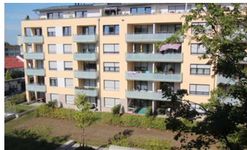
Zeilenbau mit Penthouse: Rot, Stuttgart
