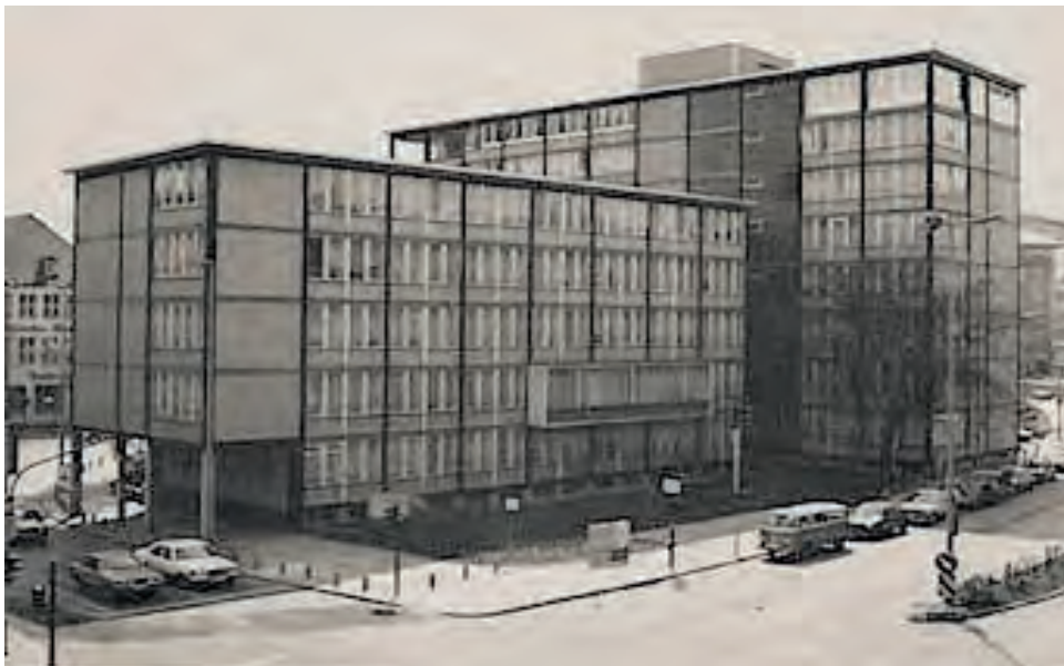
Dienstgebäude des Bundesrechnungshofes in Frankfurt am Main
