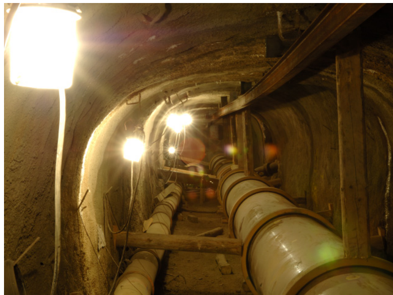
Rohrverlegung im Stollen Limburger Straße
