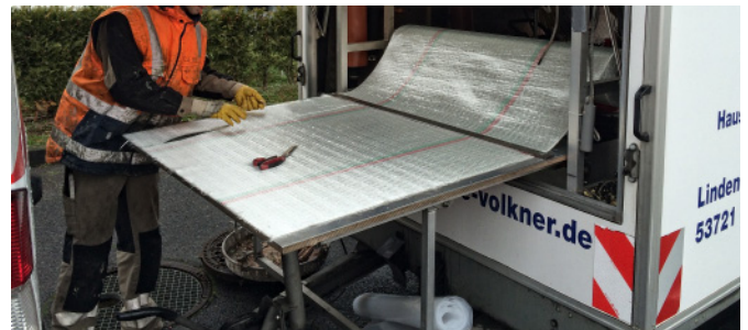
Zuschneiden der Glasfaser-Matte
