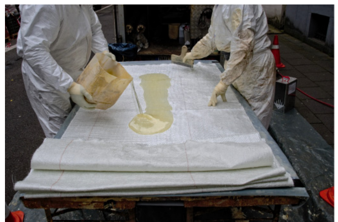
Tränkung der Glasfaser-Matte
