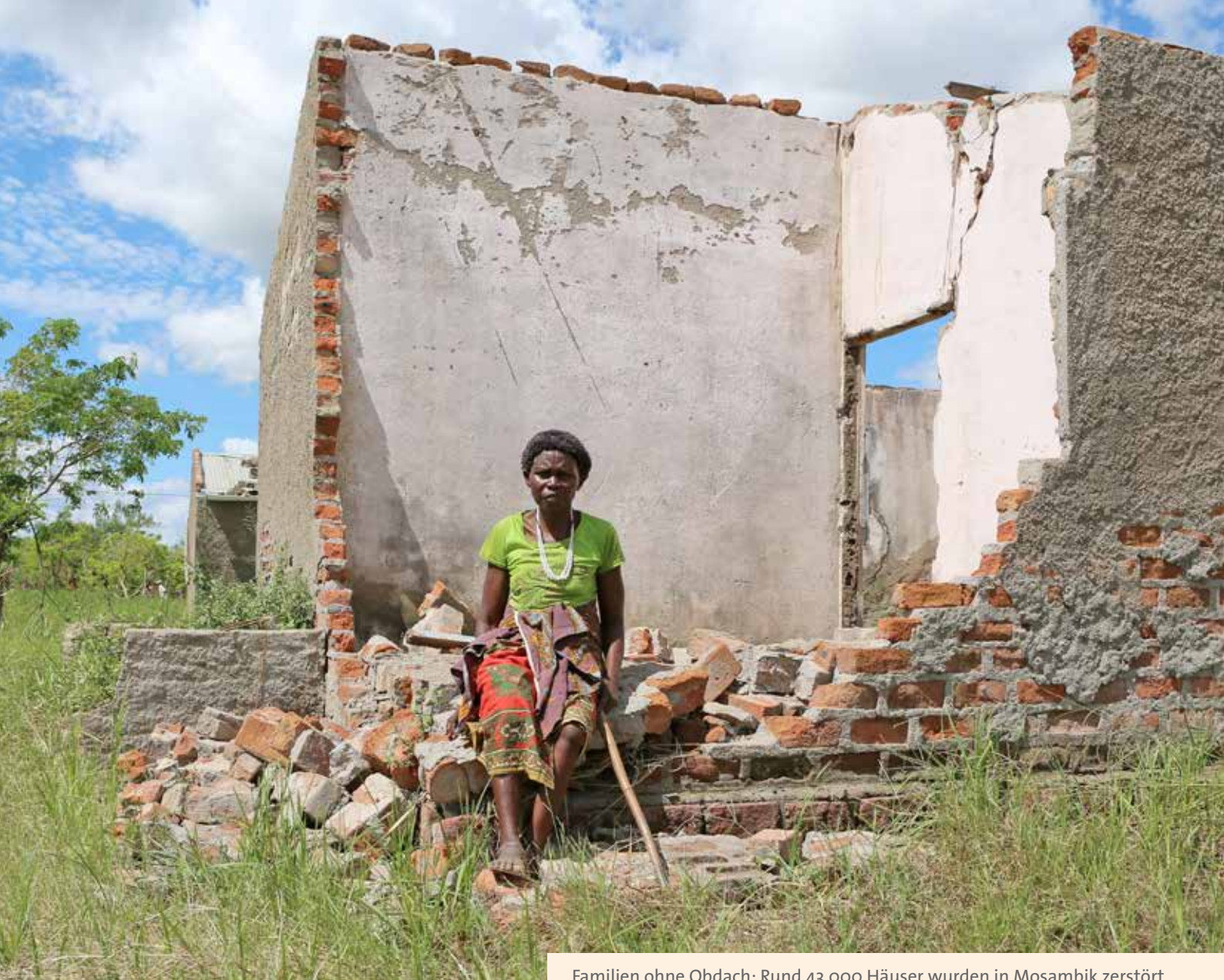
Familien ohne Obdach: Rund 43.000 Häuser wurden in Mosambik zerstört.
