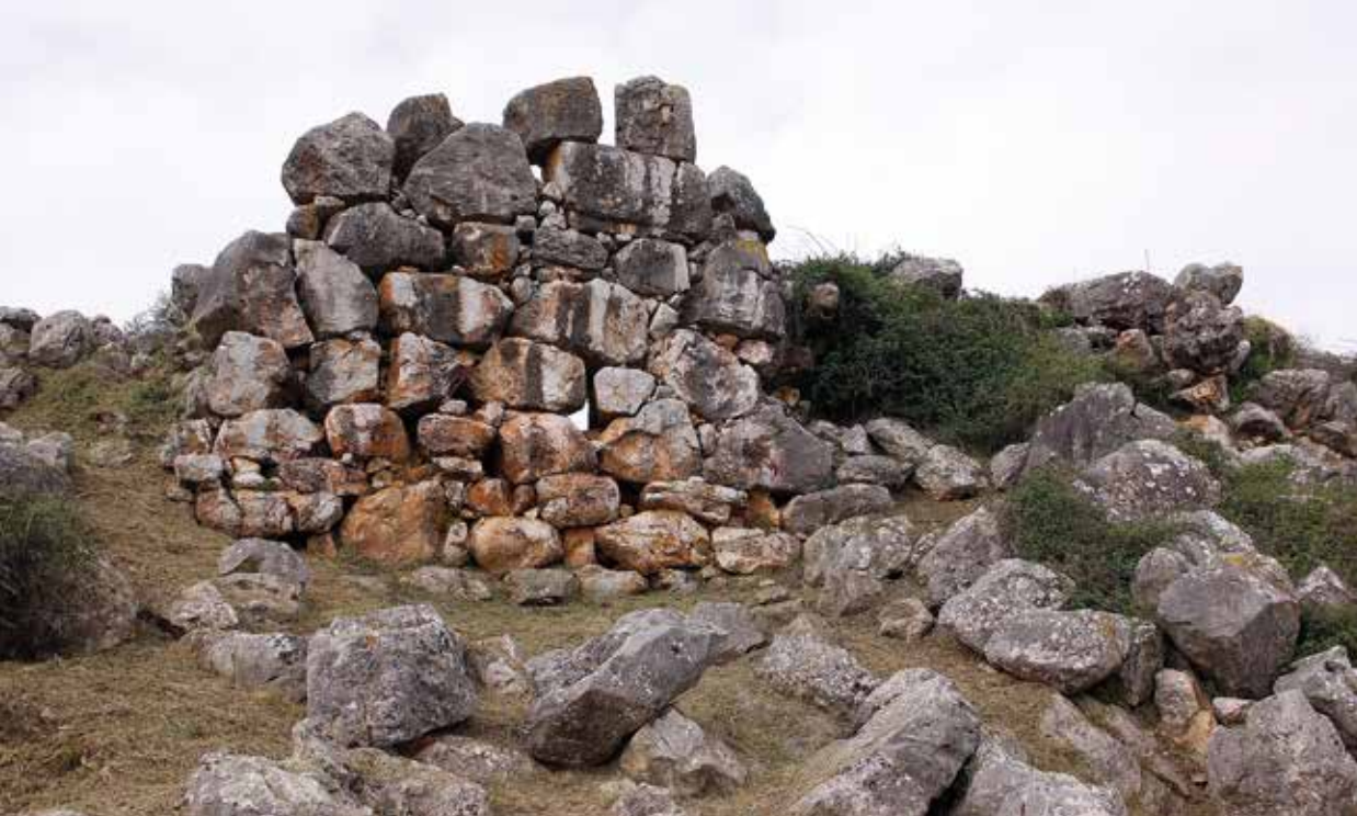
Unterburg Tiryns, Außenansicht Ostmauer auf Höhe der Mauernische KO4.
