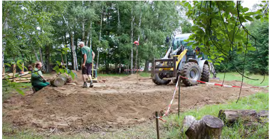
Einbau einer Sandfläche mit einer Einfassung aus Baumstämmen im NER „Wilde Welt“ an der Moorwiese, Berlin (Claudia Friede)
